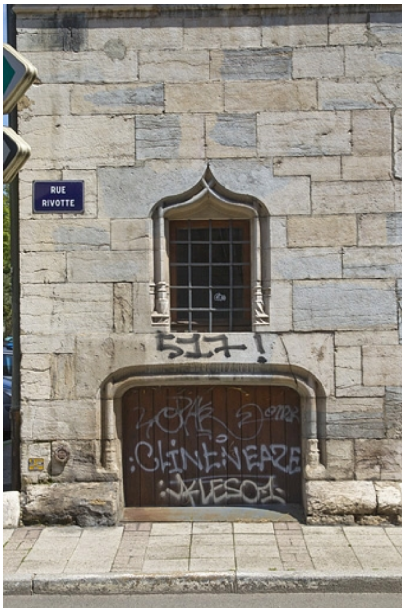
Façade antérieure, vue de l'entrée de cave.
