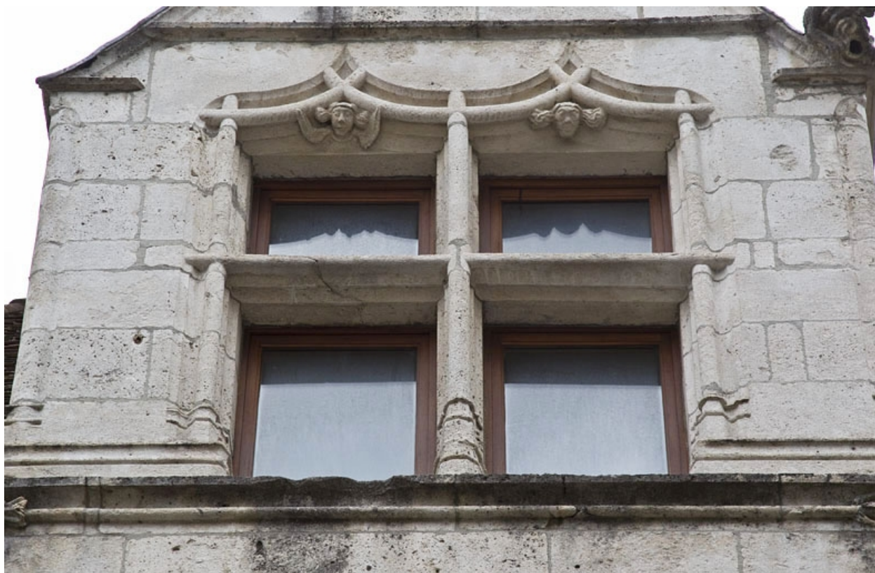
Façade antérieure, lucarne : détail de la fenêtre.
