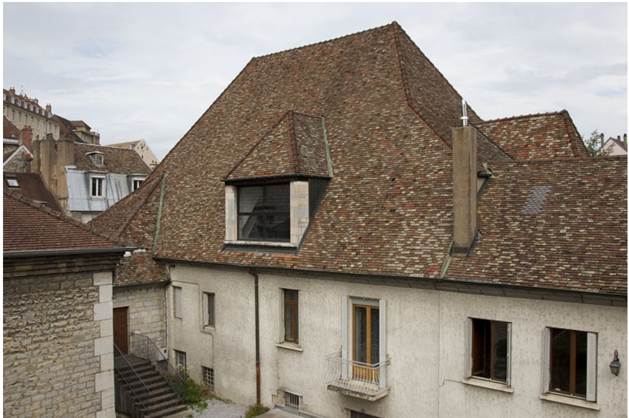
Façade latérale droite, de trois quarts droit.
