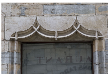
Façade antérieure : détail de l'arc en accolade de la baie à gauche l'ancienne entrée.
