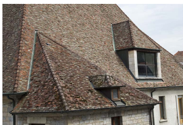
Détail du pan de toiture au- dessus de la façade latérale droite.
