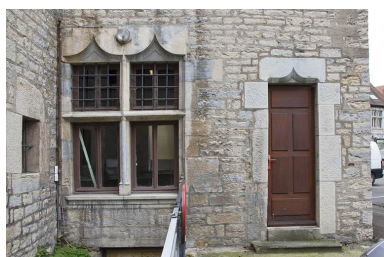
Façade postérieure : détail du rez-de-chaussée. Phot. Yves Sancey IVR43_20112501698NUC2A
