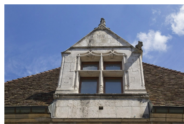
Façade antérieure, lucarne : vue d'ensemble.
