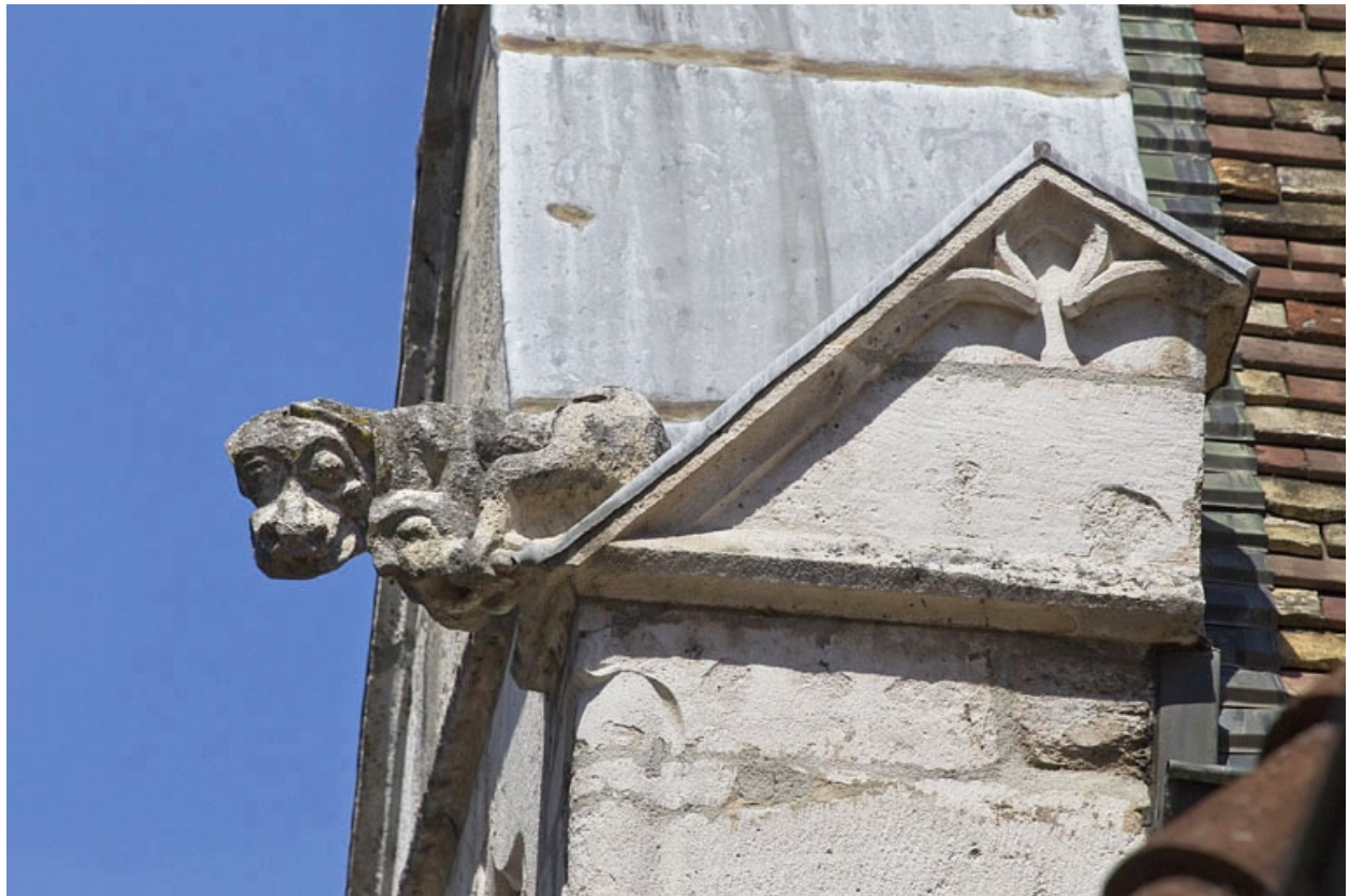
Façade antérieure, lucarne : détail d'une gargouille.
