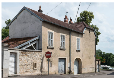
L'édifice depuis la rue Grande. Phot. Jérôme Mongreville IVR43_20187000291NUC4A
