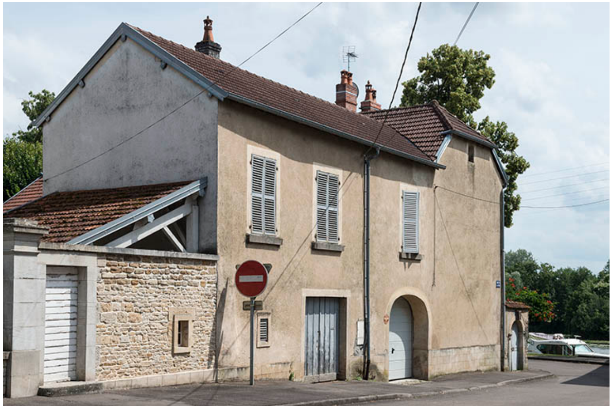
L'édifice depuis la rue Grande.
