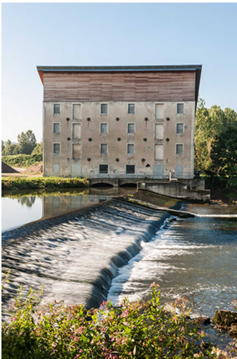
Façade nord depuis l'extrémité du barrage.
