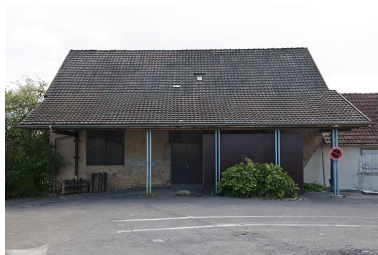
Dépendance de la ferme. Phot. Jérôme Mongreville IVR43_20122501835NUC4A
