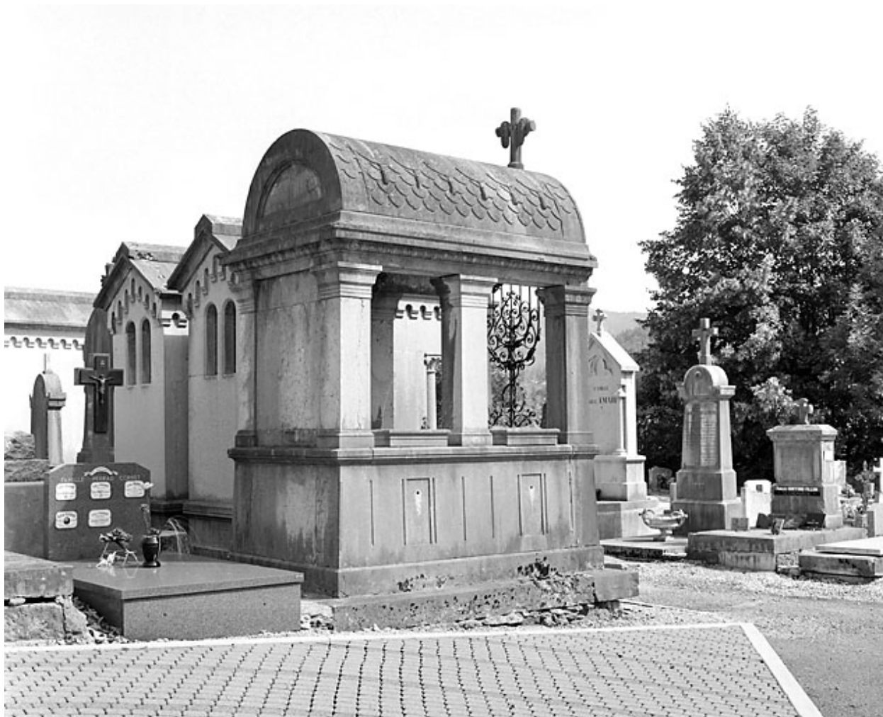
Façades postérieure et latérale gauche.
