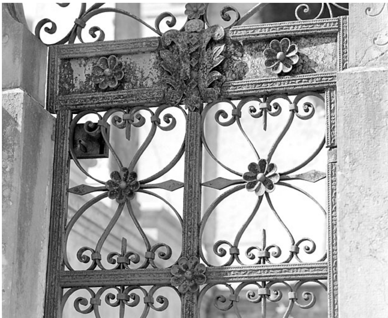
Grille : détail de la partie basse.
