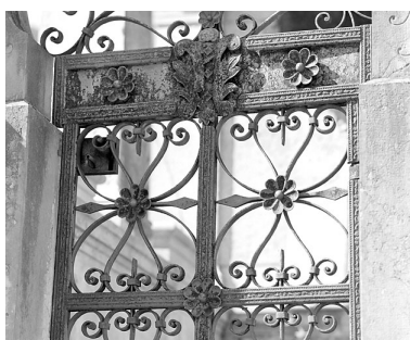
Grille : détail de la partie basse. Phot. Yves Sancey IVR43_20033901073X
