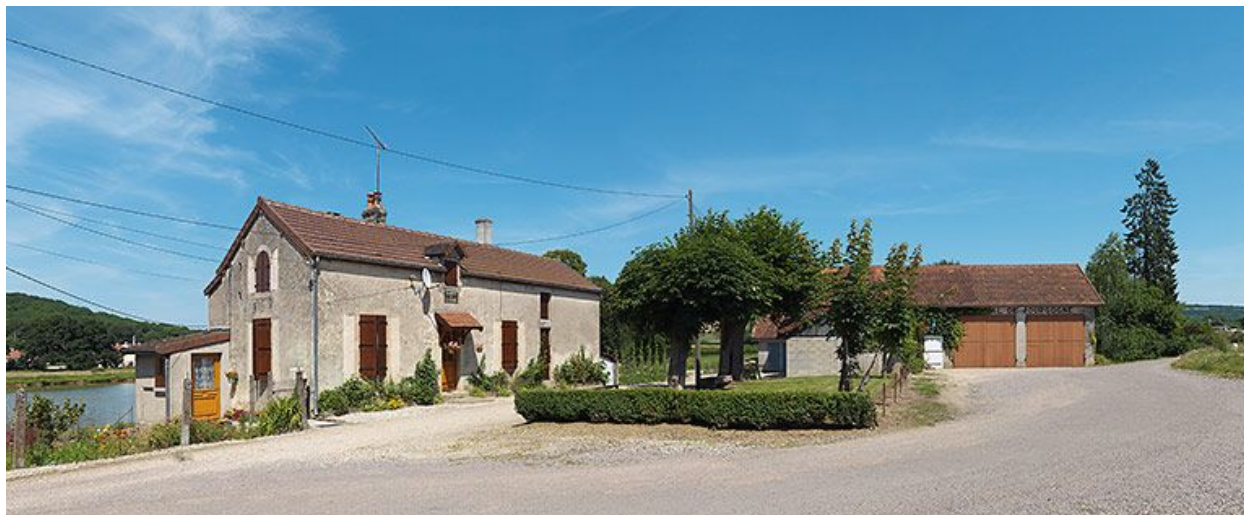
Vue d'ensemble de la maison de garde.
