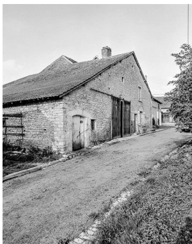
Façades antérieure et latérale gauche.
