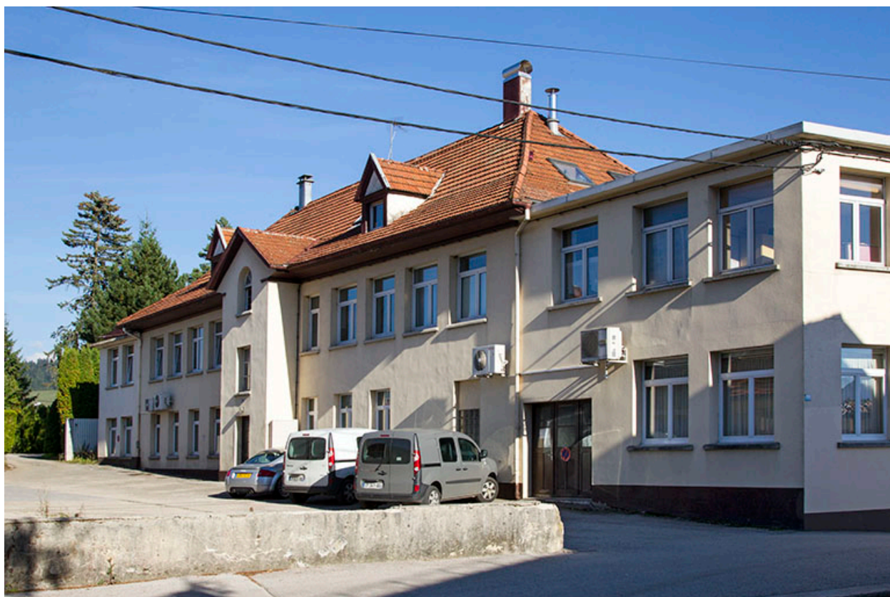
Usine : façade postérieure, de trois quarts droite.
