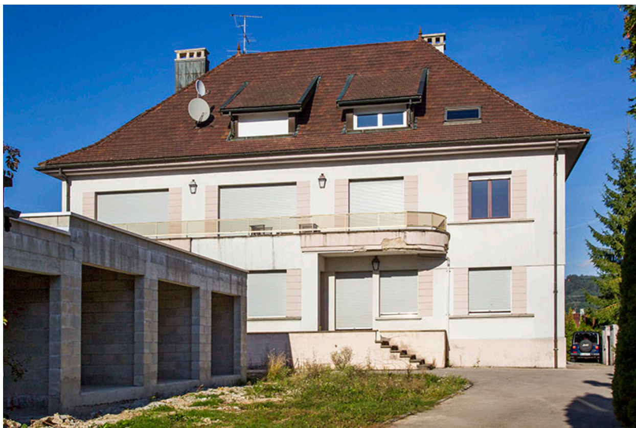
Maison : façade côté usine.
