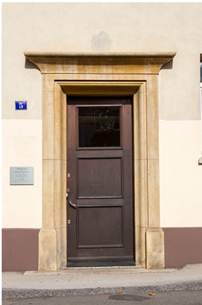
Usine : façade antérieure, porte principale.
