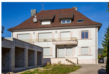
Maison : façade côté usine. Phot. Yves Sancey IVR43_20132502420NUC2A
