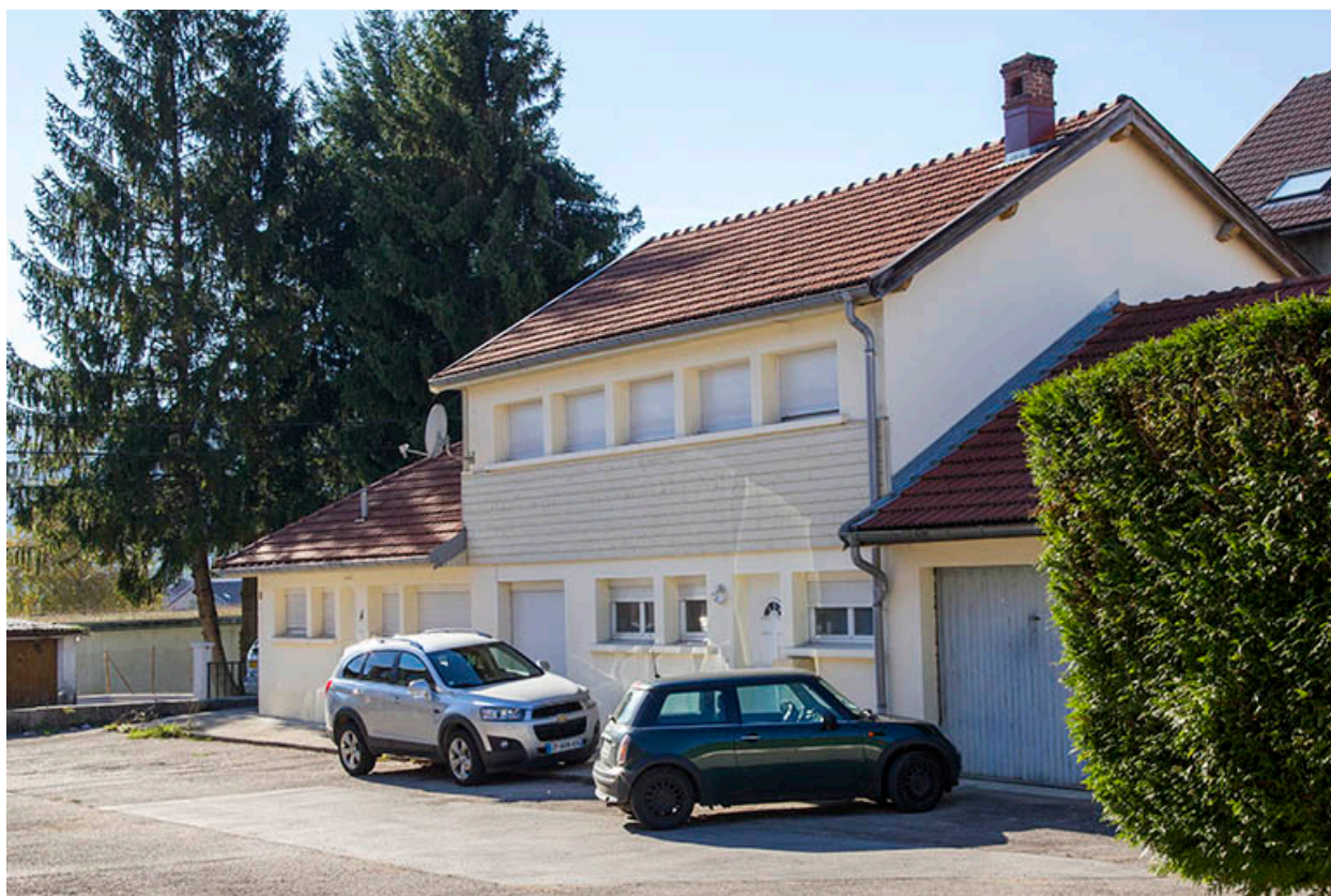
Bâtiment sur cour, de trois quarts droite.
