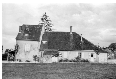
Façade postérieure. Phot. Guy Forestier IVR43_19753900069Z
