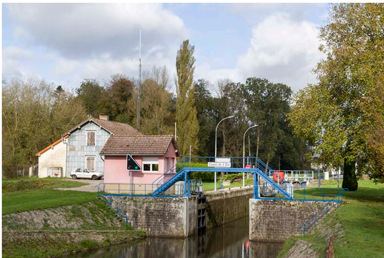
Vue du site d'écluse depuis l'aval.
