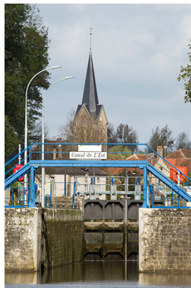
Vue rapprochée de l'écluse vue de l'aval. Phot. Sonia Dourlot IVR43_20157000136NUC2A
