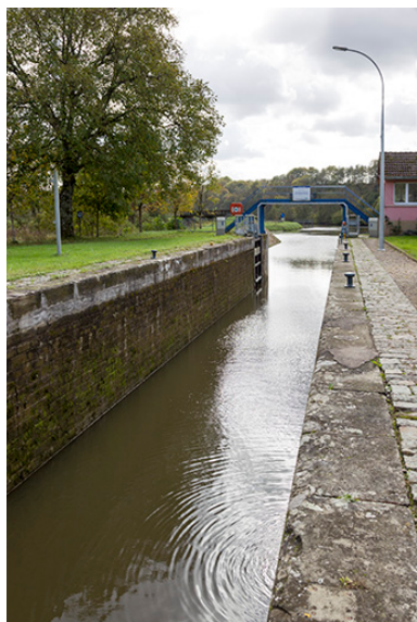
Vue de l'écluse vers l'aval. Phot. Sonia Dourlot IVR43_20157000132NUC2A
