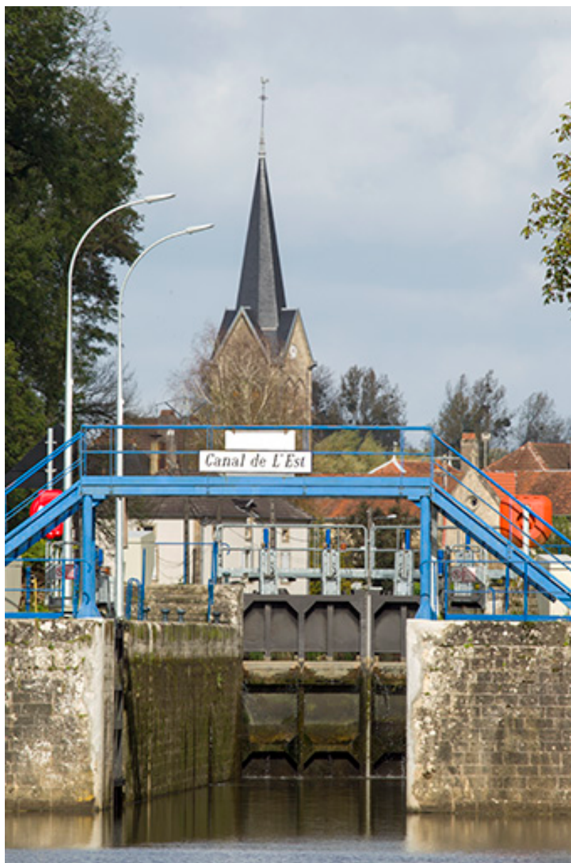
Vue rapprochée de l'écluse vue de l'aval.
