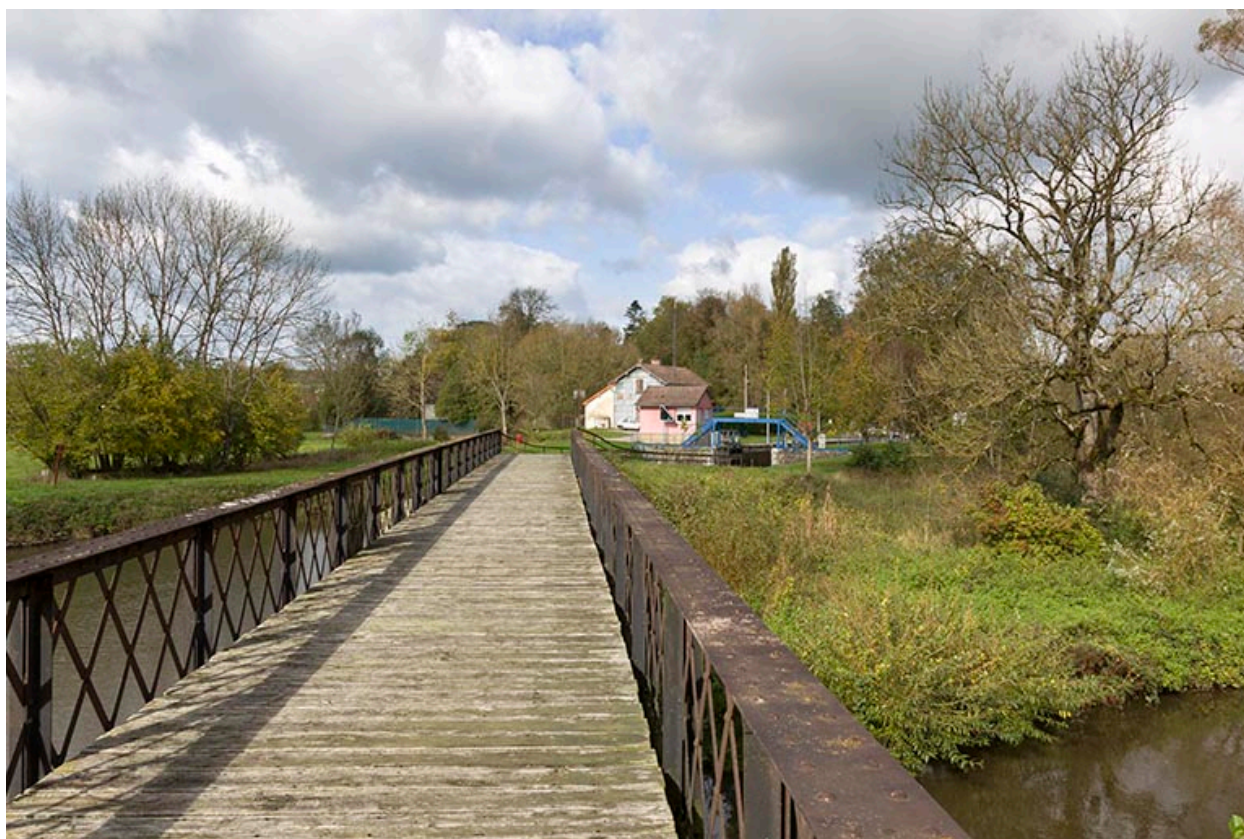
Détail de la passerelle enjambant le Coney.
