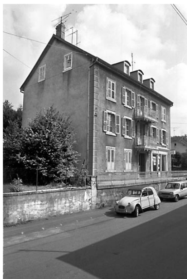
Vue d'ensemble. Phot. Bernard Lardière IVR43_19829000143Z
