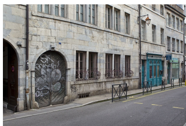
Façade sur rue du logis principal : détail du rez-de-chaussée. Phot. Yves Sancey IVR43_20102500823NUC2A
