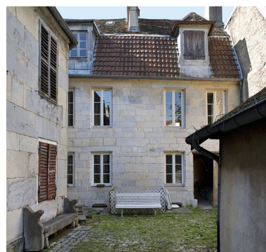
Vue d'ensemble de la façade postérieure du premier logis secondaire. Phot. Yves Sancey IVR43_20102500819NUC2A
