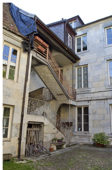
Vue d'ensemble de l'escalier à cage ouverte. Phot. Yves Sancey IVR43_20102500829NUC2A
