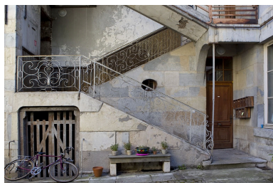
Détail du départ de l'escalier à cage ouverte dans la première cour. Phot. Yves Sancey IVR43_20102500826NUC2A
