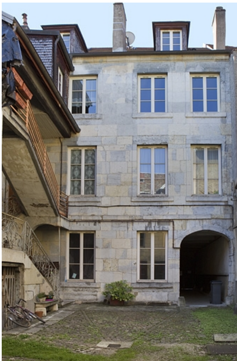
Façade postérieure du logis principal.
