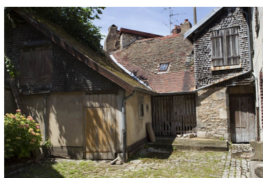
Vue d'ensemble des petits bâtiments et du bûcher au fond de la deuxième cour. Phot. Yves Sancey IVR43_20102500835NUC2A
