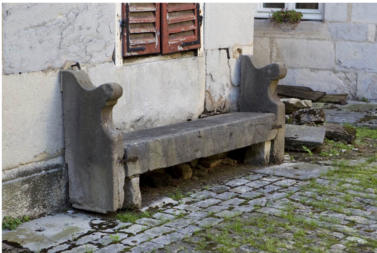
Détail d'un banc en pierre dans la deuxième cour.
