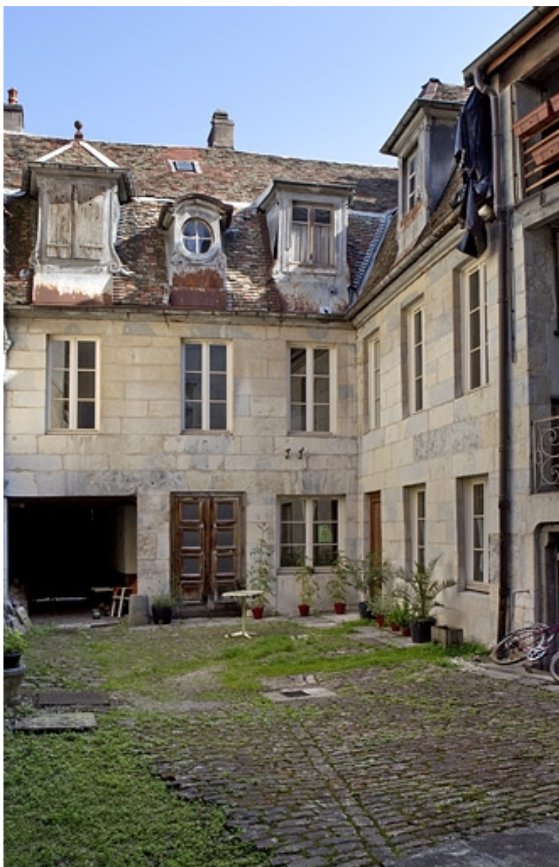
Façade antérieure du premier logis secondaire.
