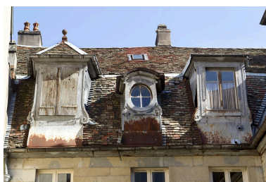
Toit du premier logis secondaire sur la première cour : détail des lucarnes. Phot. Yves Sancey IVR43_20102500834NUC2A
