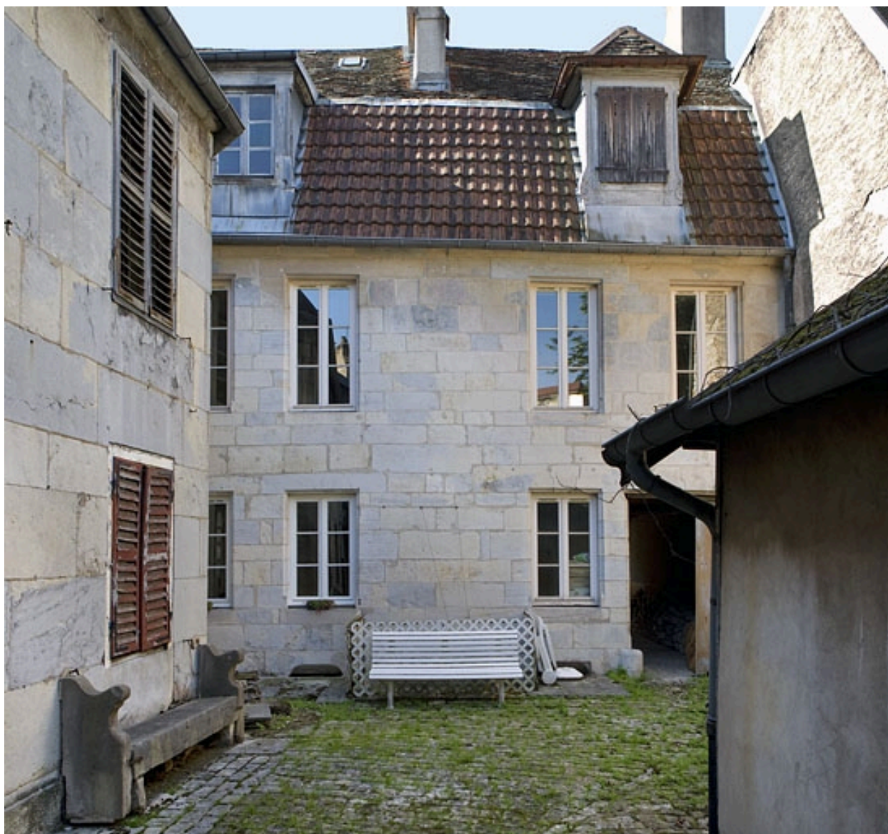
Vue d'ensemble de la façade postérieure du premier logis secondaire.
