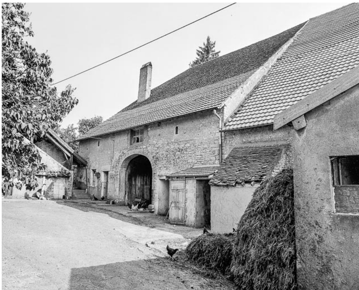
Bâtiment de droite : façade antérieure.
