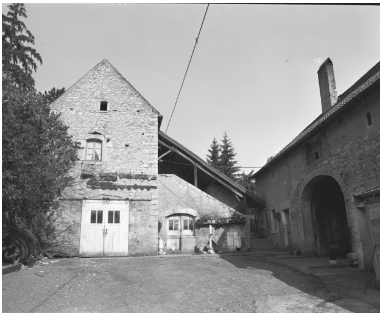
Ensemble des bâtiments : façades sur cour.
