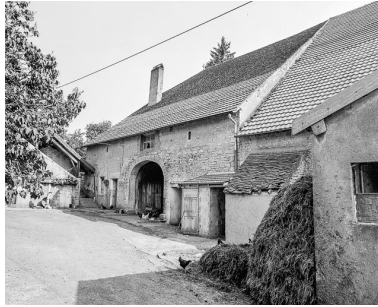
Bâtiment de droite : façade antérieure. Phot. Dominique Humbert IVR43_19767000475X
