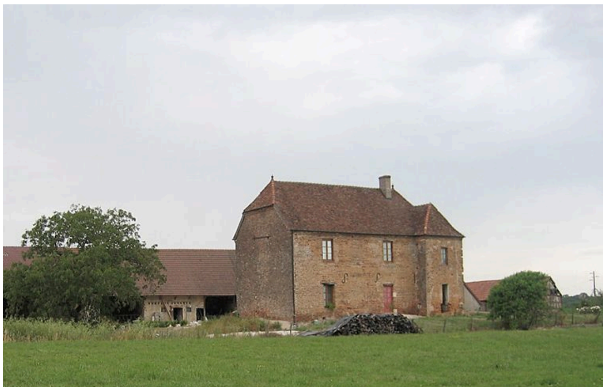
Exemple d'une ferme à La Chaux.
