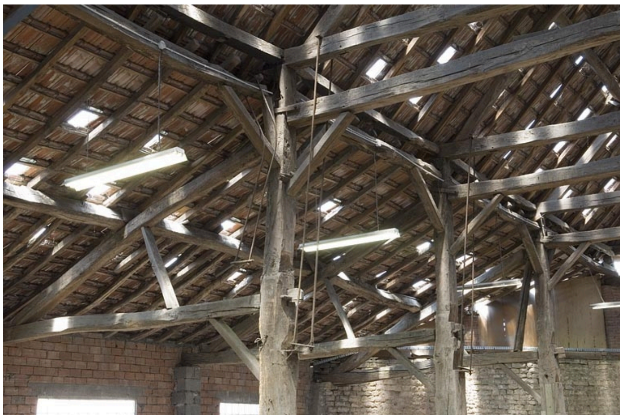
Magasin industriel. Détail de la charpente.
