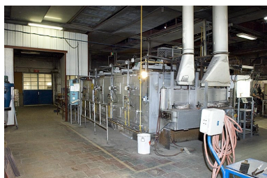
Four à cuire (arche). Phot. Jérôme Mongreville IVR43_20077000923NUCA
