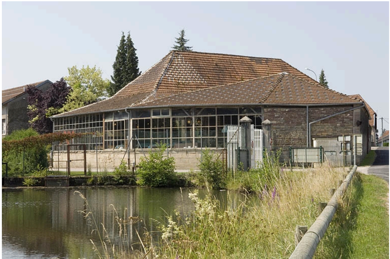
Ancien séchoir à bois depuis le nord-est.
