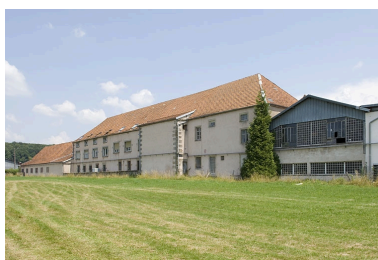
Façades ouest vues de trois quarts droite. Phot. Jérôme Mongreville IVR43_20097000795NUC2A
