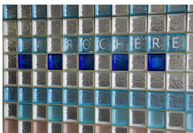
Atelier des fours. Cloison en pavés de verre. Phot. Jérôme Mongreville IVR43_20097000791NUC2A
