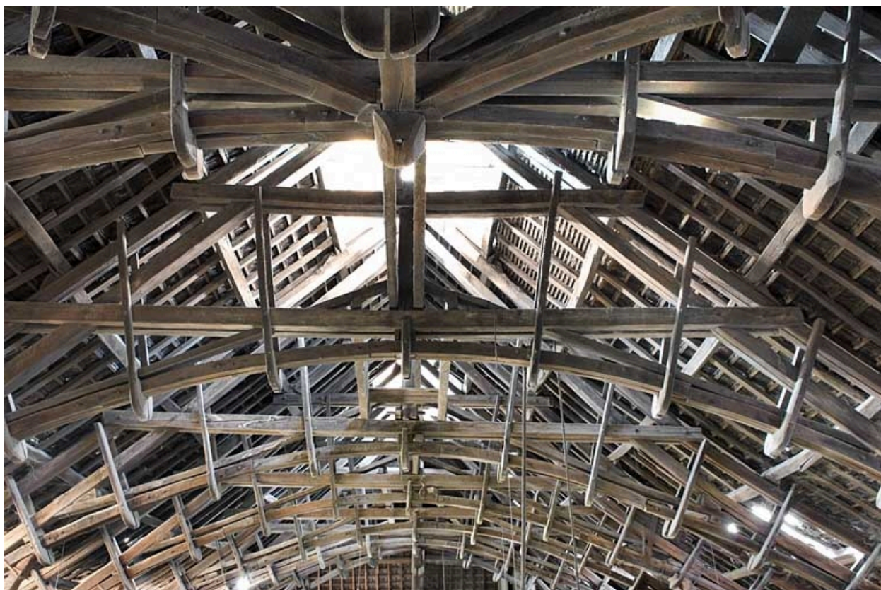
Charpente de l'atelier des fours. Détail des assemblages par étriers.
