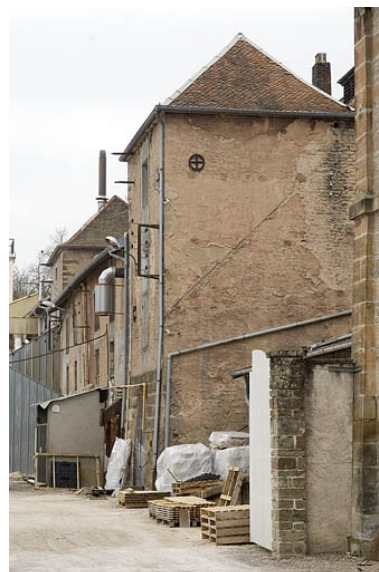
Façade postérieure de l'atelier des fours. Phot. Jérôme Mongreville IVR43_20097000563NUC2A
