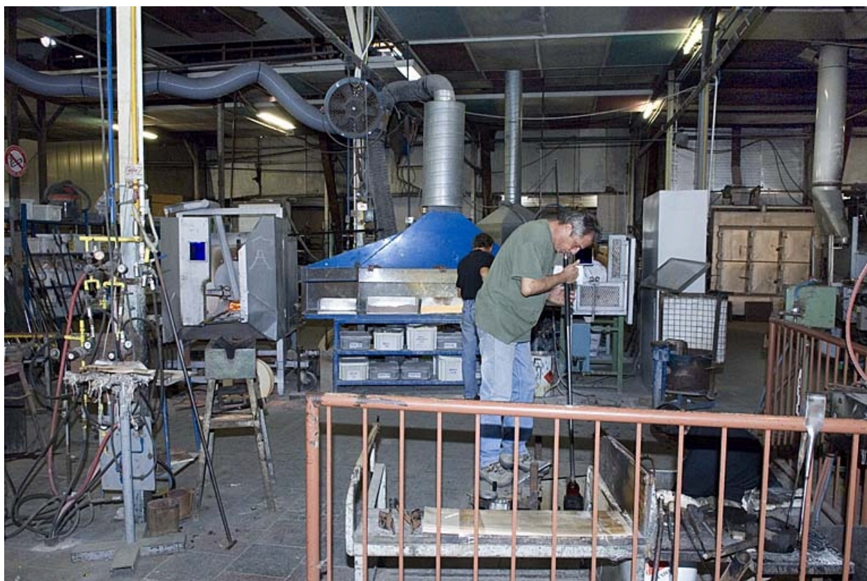
Atelier verrerie main. Vue d'ensemble depuis l'ouest.
