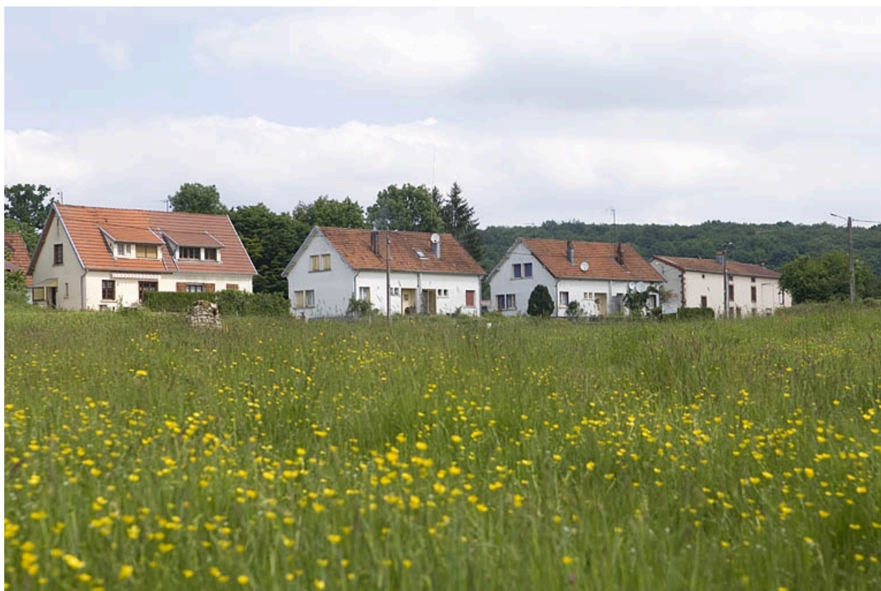
La cité ouvrière depuis le sud.
