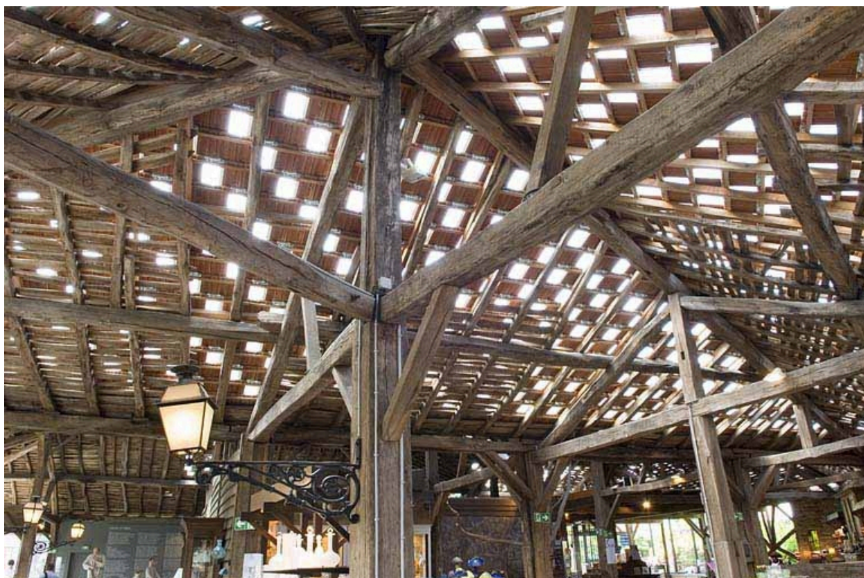
Ancien séchoir à bois. Détail de la charpente.
