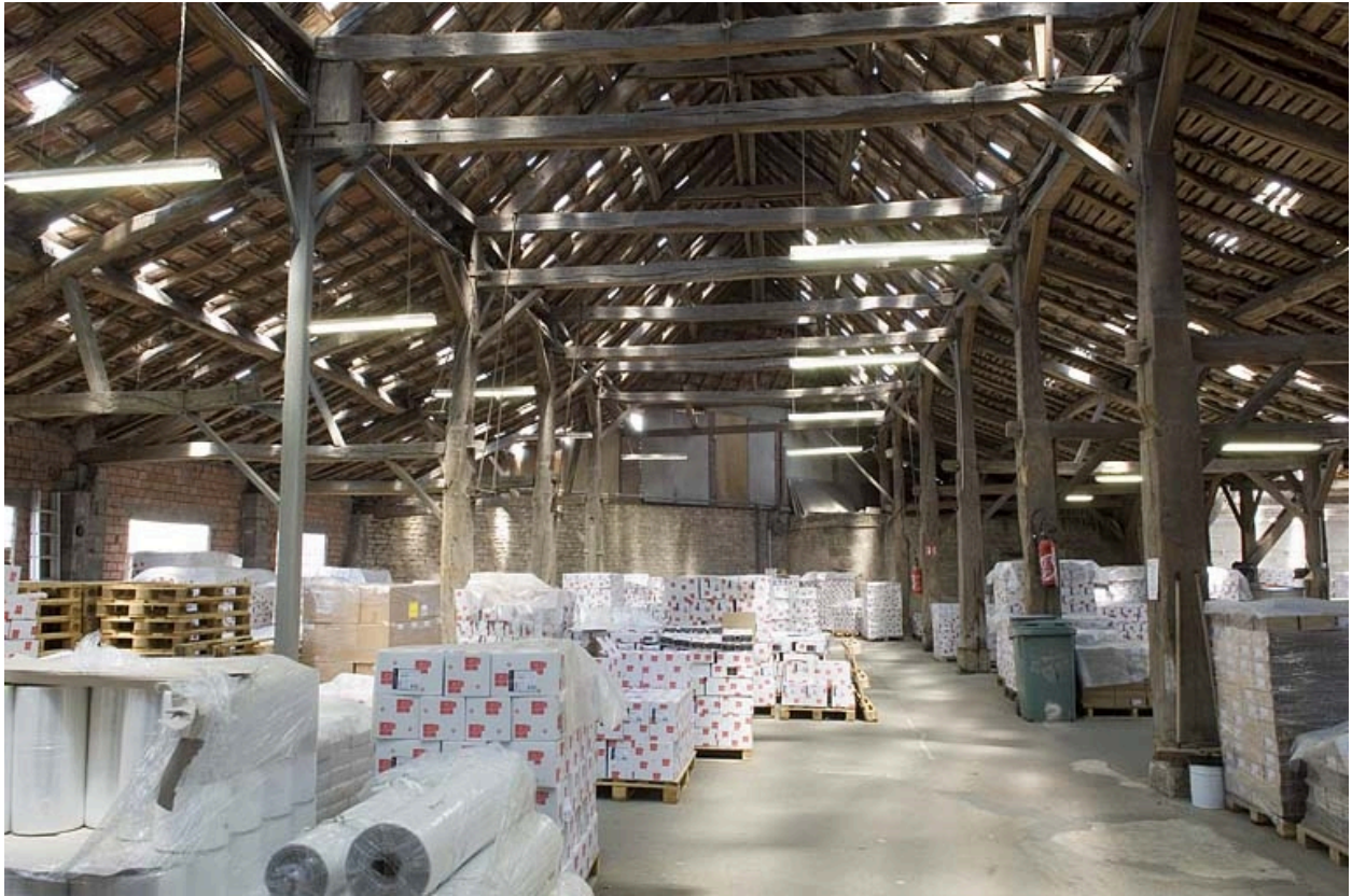
Magasin industriel. Vue intérieure.
