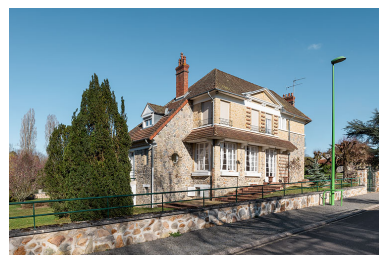
Façade sud-ouest. Phot. Pierre-Marie Barbe-Richaud IVR26_20205800293NUC4A
