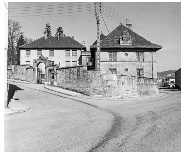
Vue d'ensemble depuis la rue, au sud-ouest. Phot. Yves Sancey IVR43_19782500005X
