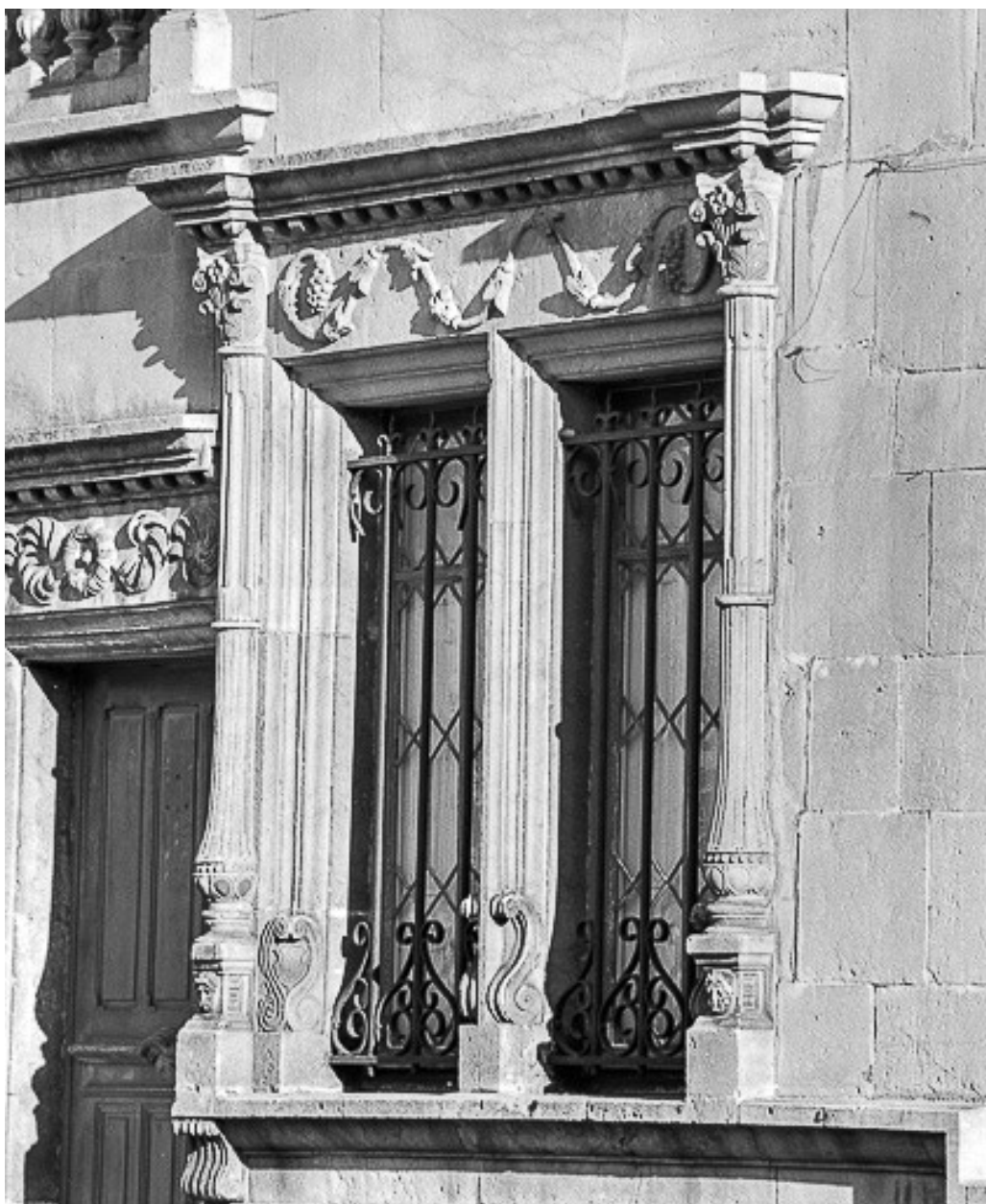
Façade sur cour, détail : fenêtre du rez-de-chaussée.
