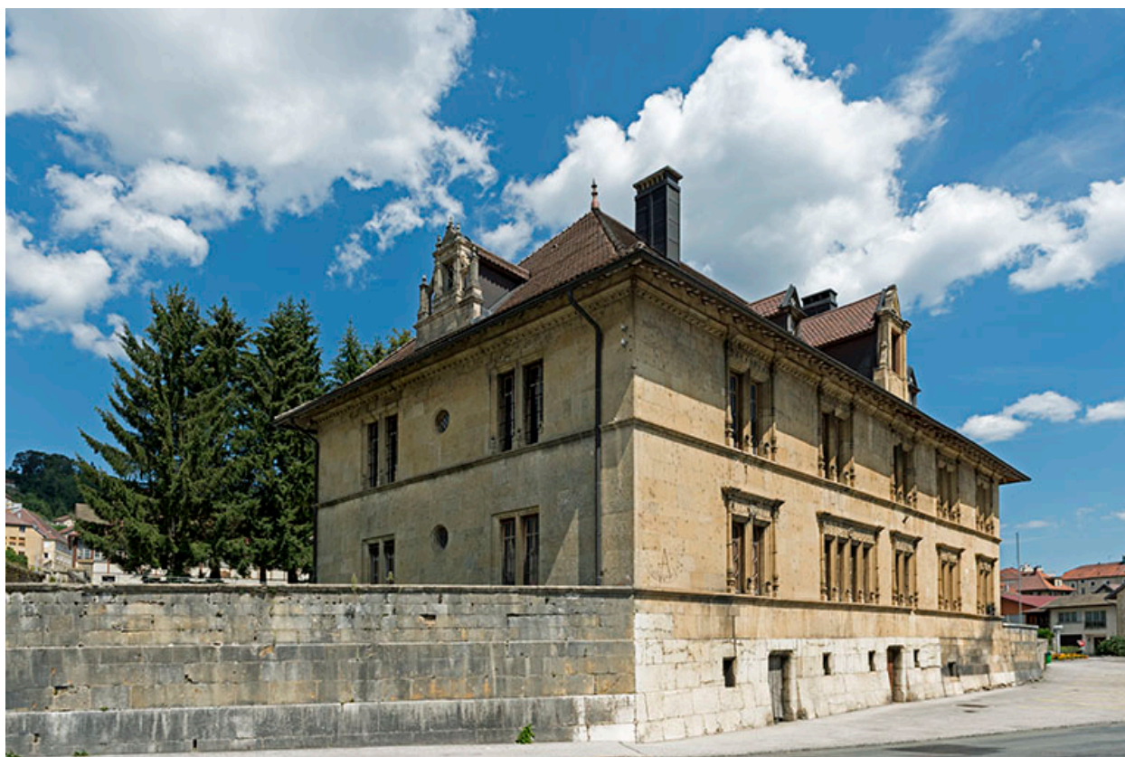
Vue d'ensemble depuis la rue, au sud.
