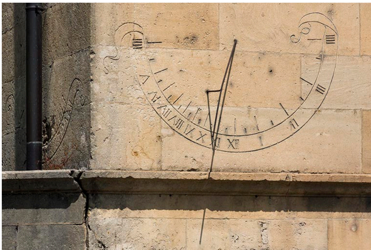
Façade sur rue : cadrans solaires.
