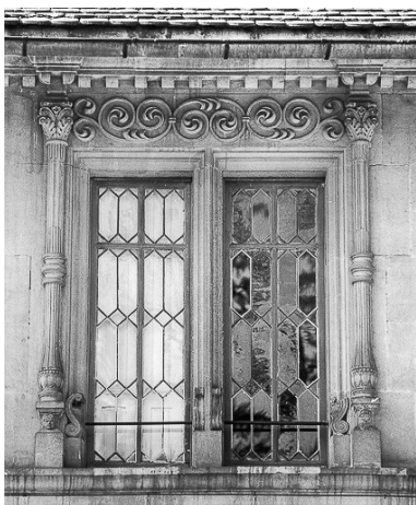
Fenêtre sur rue, à l'étage. Phot. Yves Sancey IVR43_19782500024X
