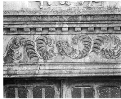
Linteau de la porte d'entrée. Phot. Yves Sancey IVR43_19782500014X
