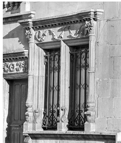
Façade sur cour, détail : fenêtre du rez-de-chaussée. Phot. Yves Sancey IVR43_19782500009X
