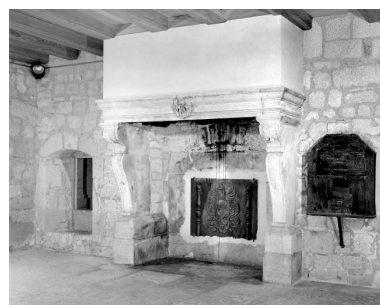
Intérieur : cheminée à manteau, le couvrement repose sur deux piedsroits. Phot. Yves Sancey IVR43_19762500794V
