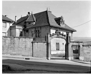
Portail d'entrée et façade sur cour. Phot. Yves Sancey IVR43_19782500004X
