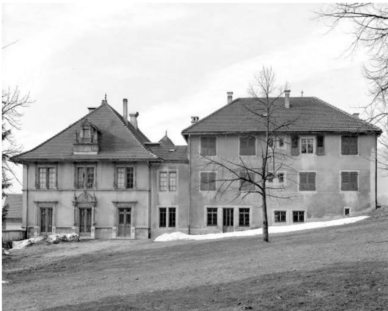
Façade sud est : vue d'ensemble.
