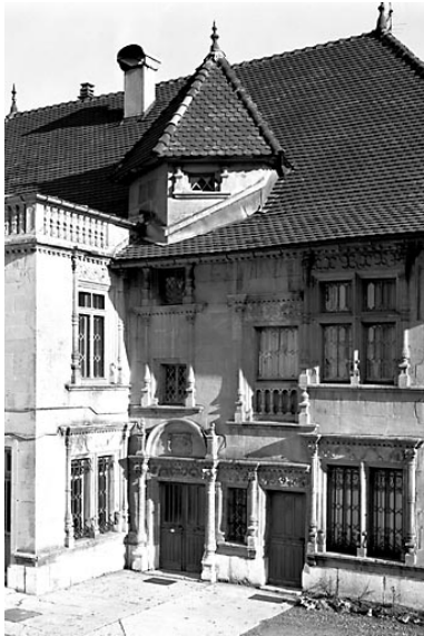
Façade sur rue. Phot. Yves Sancey IVR43_19782500001V
