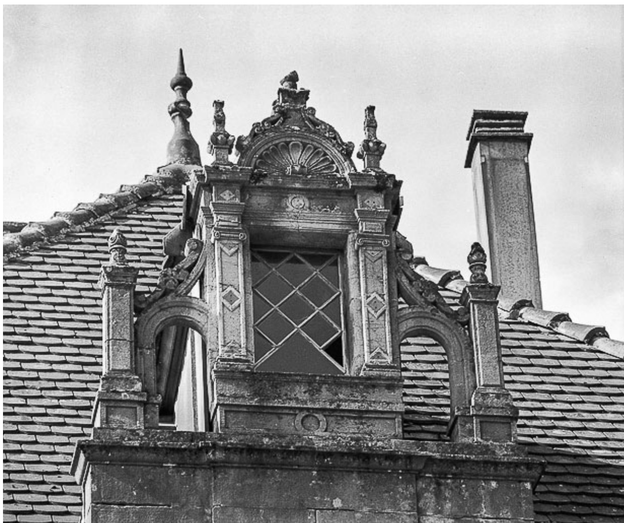
Façade latérale : lucarne.
