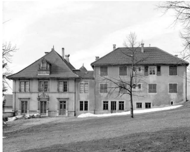
Façade sud est : vue d'ensemble. Phot. Yves Sancey IVR43_19782500020V
