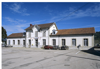
Bâtiment des voyageurs : vue d'ensemble, de trois quarts droite. Phot. Yves Sancey IVR43_20043900128XA
