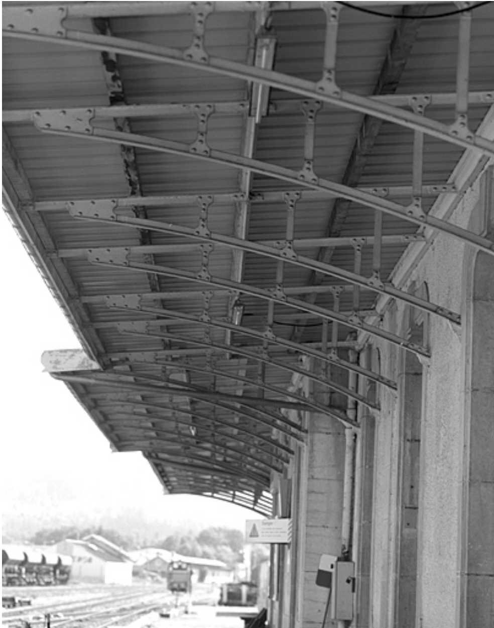
Bâtiment des voyageurs : vue d'ensemble des consoles métalliques soutenant l'auvent.
