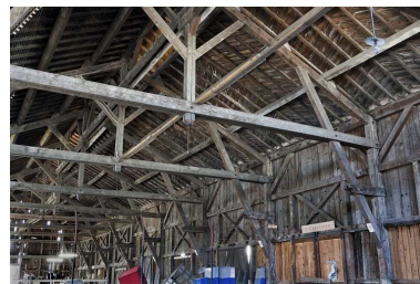
Entrepôt : mur sud et charpente. Phot. Yves Sancey IVR43_20073900150NUCA
