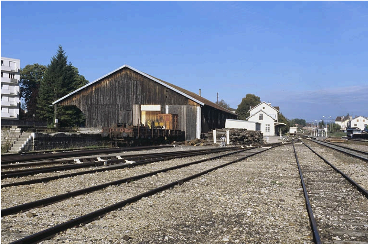
Entrepôt : vue d'ensemble, depuis le sud-est.
