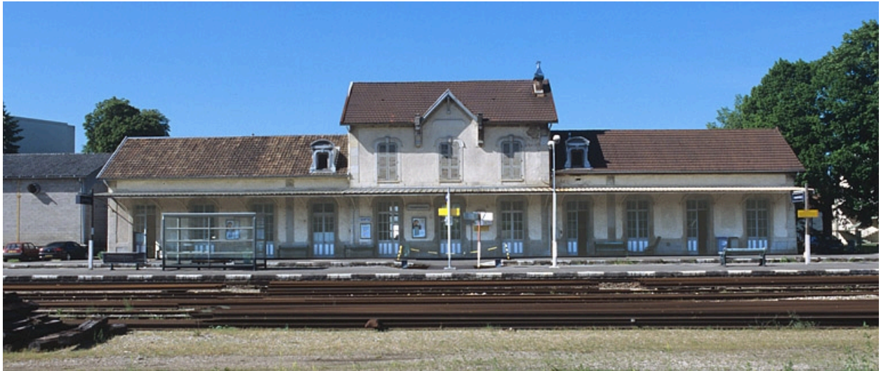
Bâtiment des voyageurs : façade postérieure.
