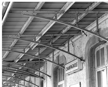
Bâtiment des voyageurs : consoles métalliques soutenant l'auvent. Phot. Yves Sancey IVR43_20043900168X
