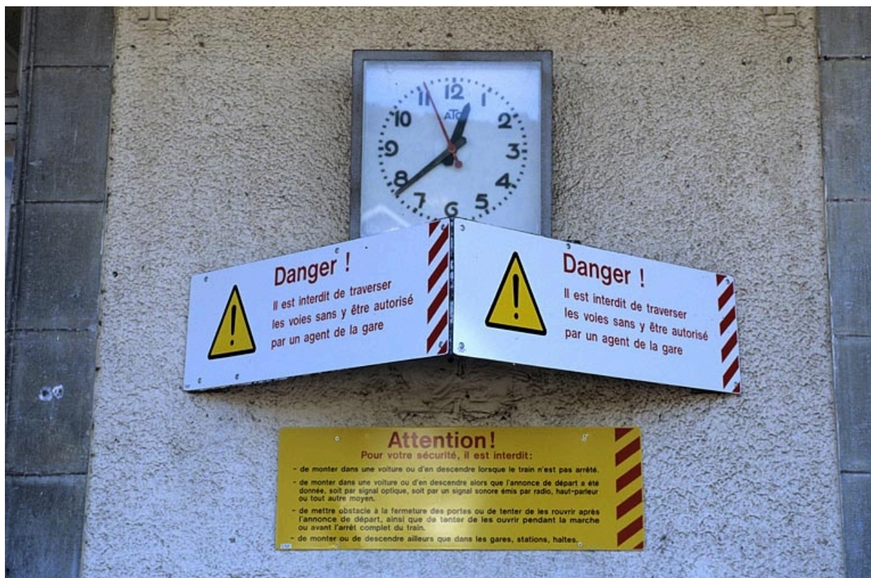
Bâtiment des voyageurs : horloge et panneaux d'avertissement.
