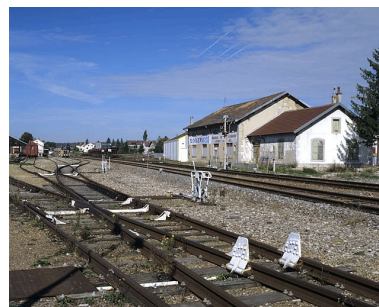
Vue d'ensemble de la remise ferroviaire (actuellement magasin de commerce), depuis le sud. Phot. Yves Sancey IVR43_20043900134XA
