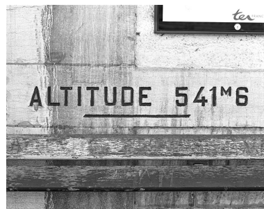
Bâtiment des voyageurs : inscription altimétrique. Phot. Yves Sancey IVR43_20043900165X
