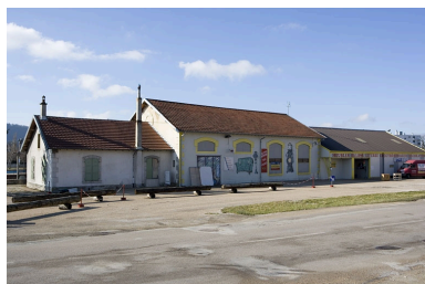
Remise ferroviaire et bureau (actuellement magasin de commerce), vus depuis l'est. Phot. Yves Sancey IVR43_20073900056NUCA
