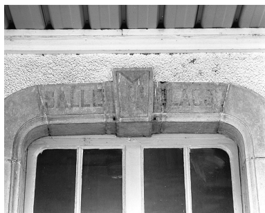
Bâtiment des voyageurs : plate- bande d'une fenêtre de la salle d'attente de troisième classe. Phot. Yves Sancey IVR43_20043900167X
