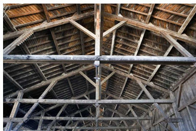
Entrepôt : charpente. Phot. Yves Sancey IVR43_20073900149NUCA
