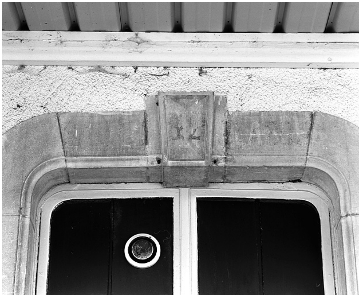
Bâtiment des voyageurs : plate-bande d'une fenêtre.
