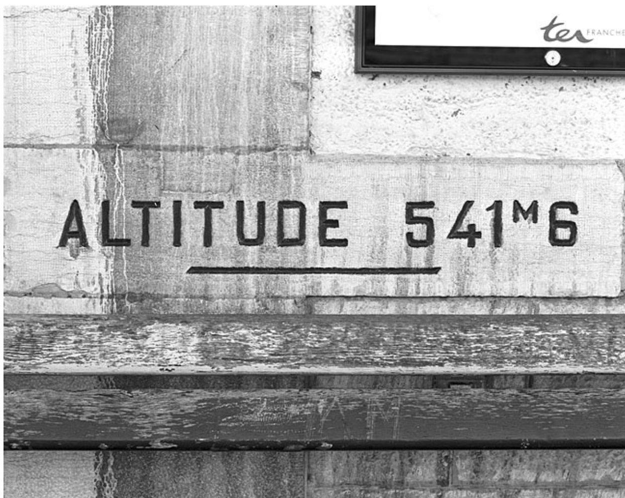
Bâtiment des voyageurs : inscription altimétrique.
