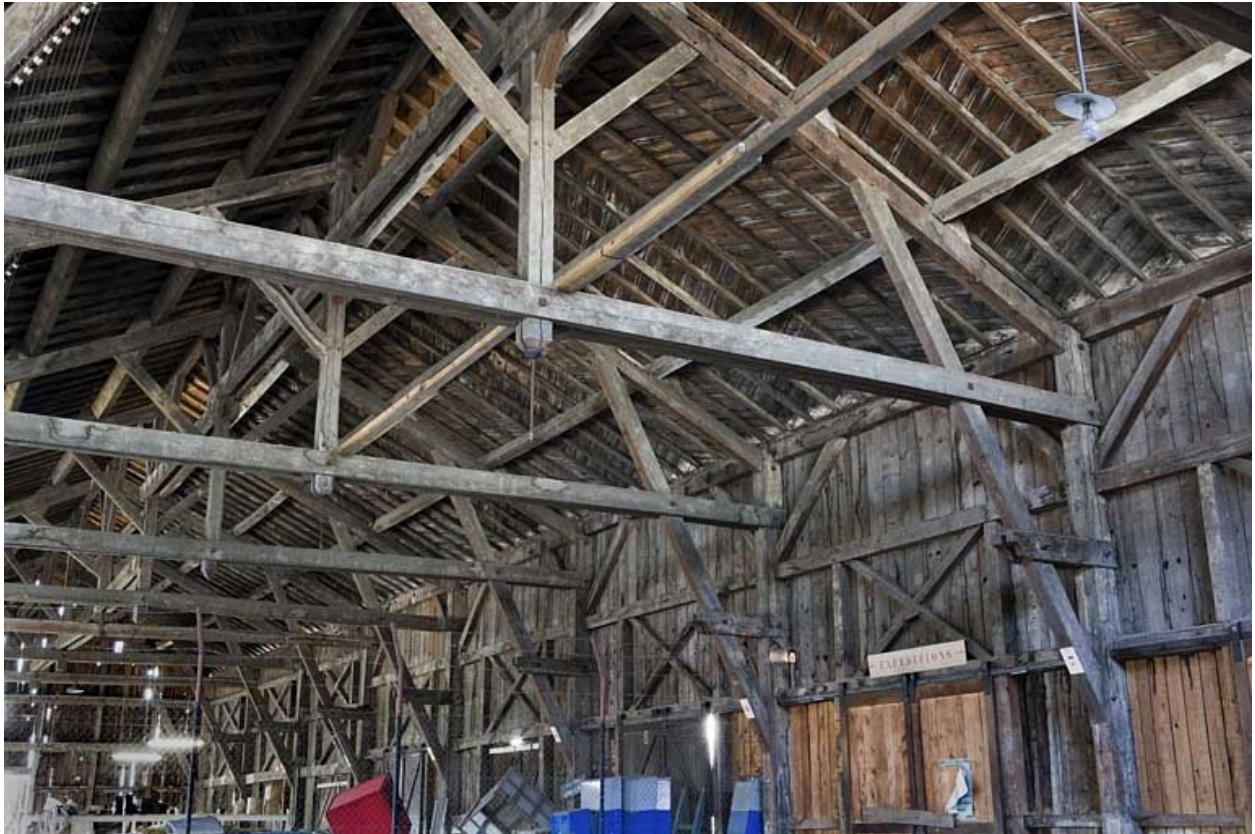
Entrepôt : mur sud et charpente.
