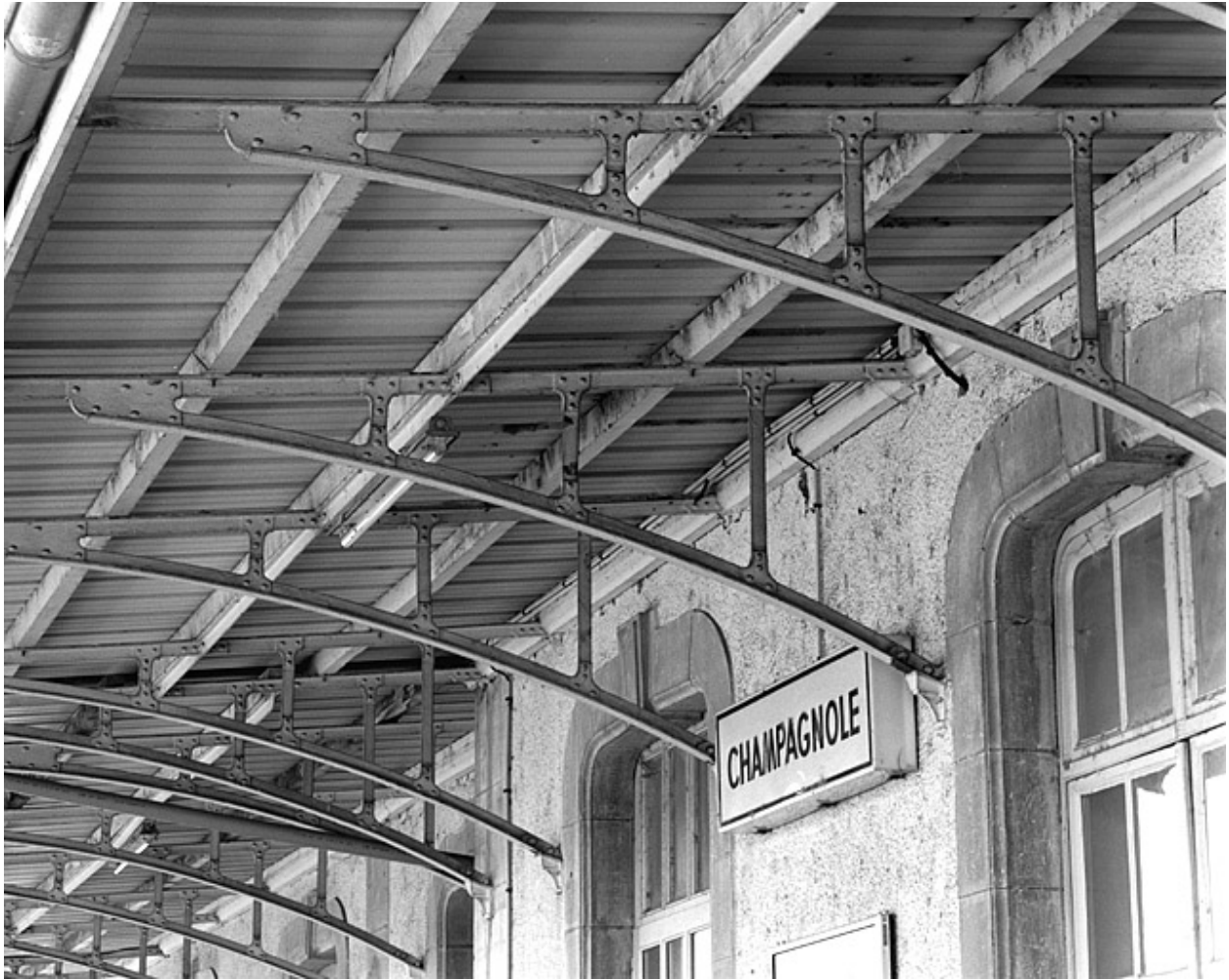
Bâtiment des voyageurs : consoles métalliques soutenant l'auvent.
