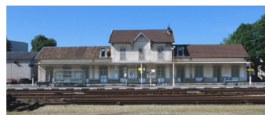
Bâtiment des voyageurs : façade postérieure. Phot. Yves Sancey IVR43_20053900068ZA
