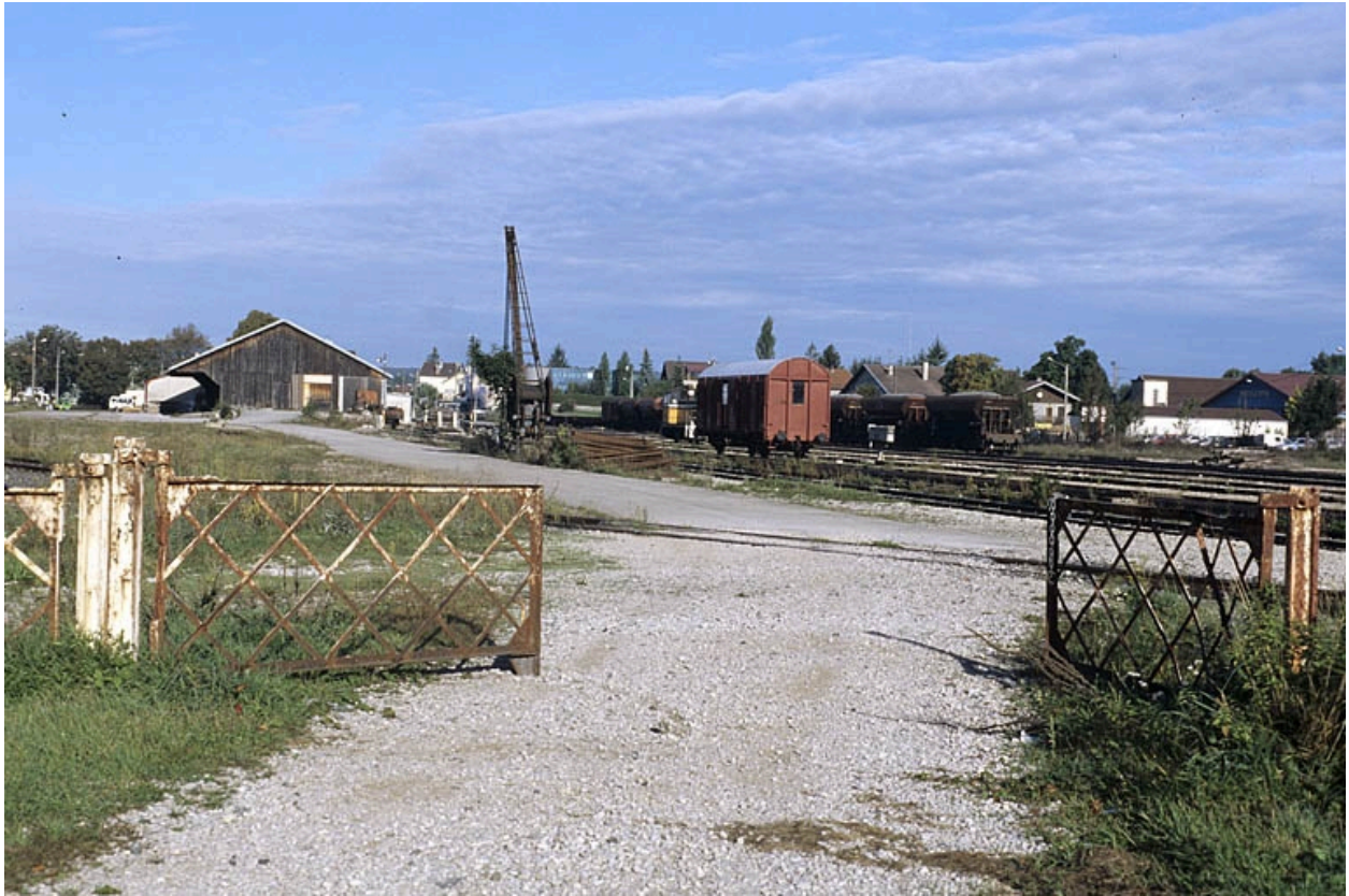
Vue d'ensemble de la grue et des voies, depuis le sud-est.
