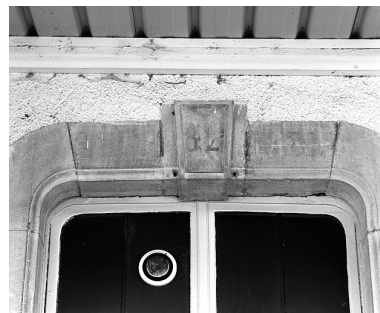
Bâtiment des voyageurs : plate-bande d'une fenêtre. Phot. Yves Sancey IVR43_20043900166X
