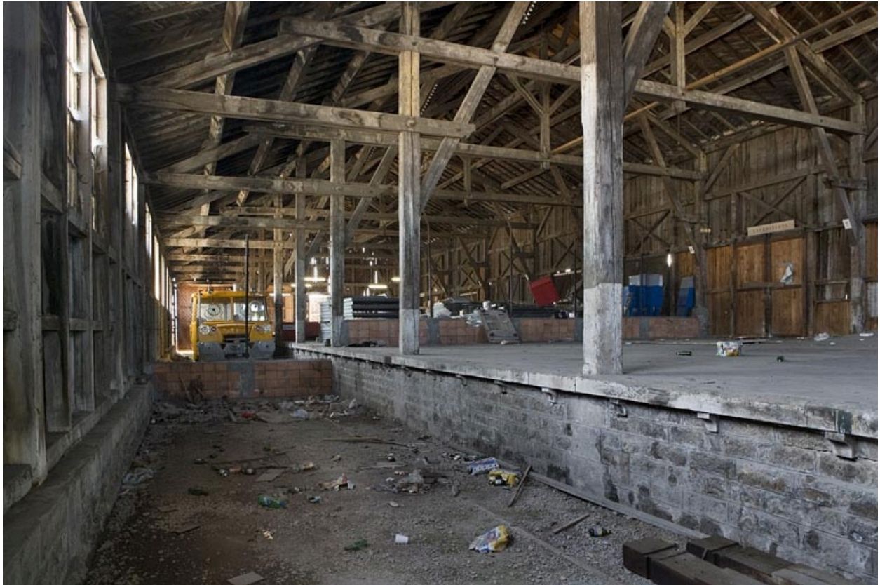
Entrepôt : intérieur, depuis l'angle nord-ouest.
