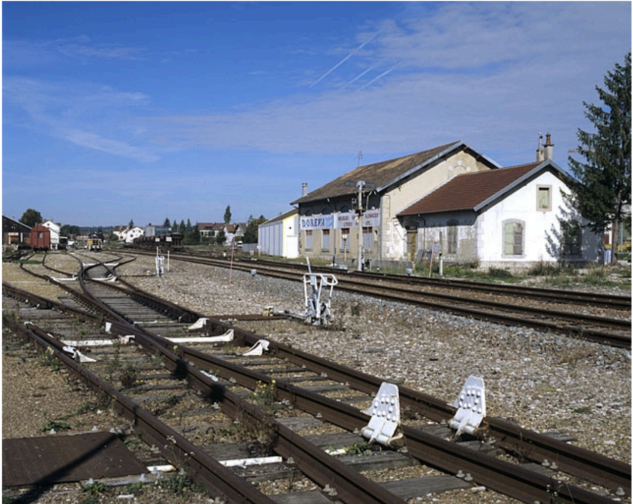
Vue d'ensemble de la remise ferroviaire (actuellement magasin de commerce), depuis le sud.
