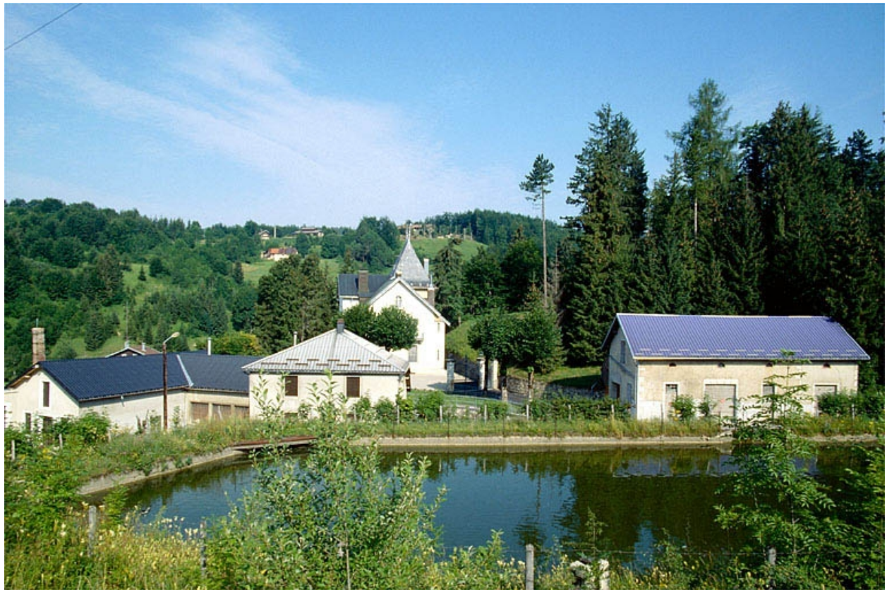
Bassin de retenue et façades sur rue.
