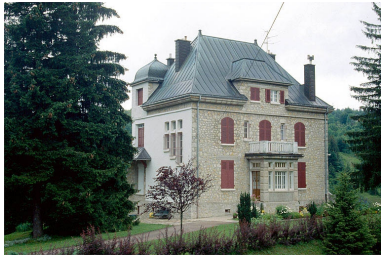
Logement patronal de 1928. Phot. Laurent Poupard IVR43_19913901595ZA
