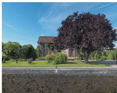
La maison éclusière de face. Phot. Thierry Kuntz IVR26_20122102042NUC4A
