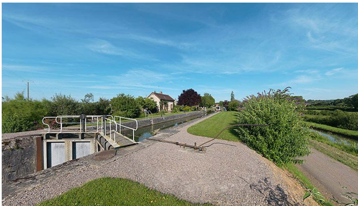
Vue d'ensemble prise d'aval.
