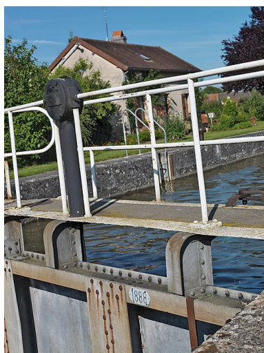
Détail des portes aval avec date portée 1888. Phot. Thierry Kuntz IVR26_20122102043NUC4A
