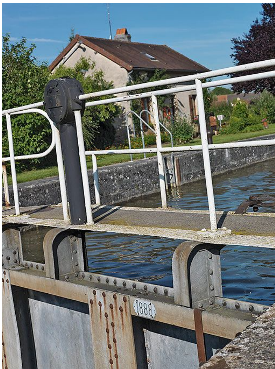
Détail des portes aval avec date portée 1888.
