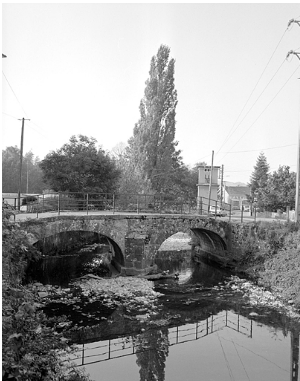
Vue du pont en amont.
