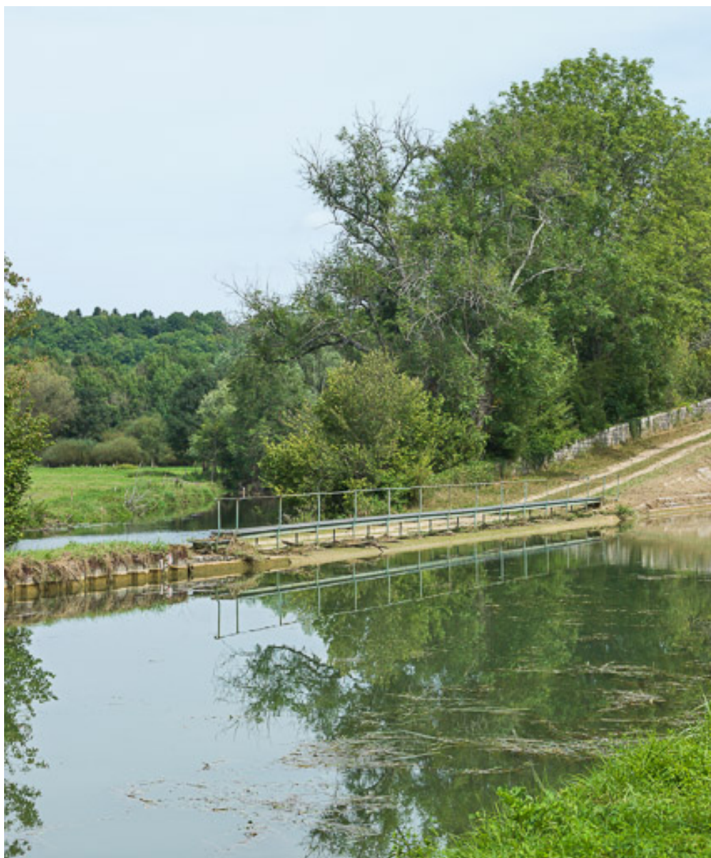
Vue du déversoir.
