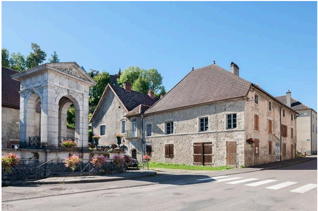
Vue d'ensemble nord-est
