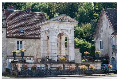
Vue générale nord Phot. Jérôme Mongreville IVR43_20137000416NUCA
