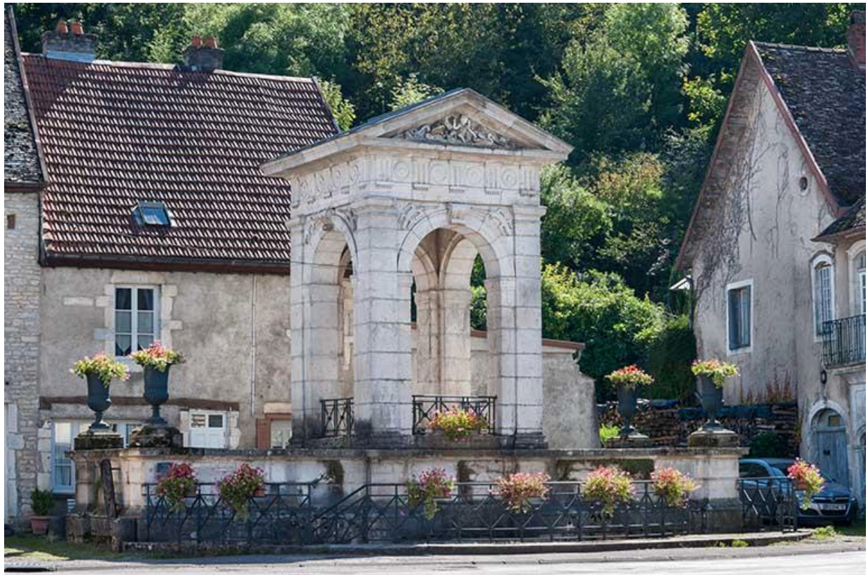
Vue générale nord
