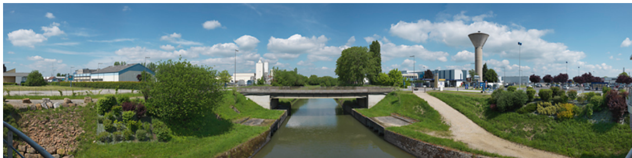
Le canal du Centre en amont du site d'écluse 34bis.
