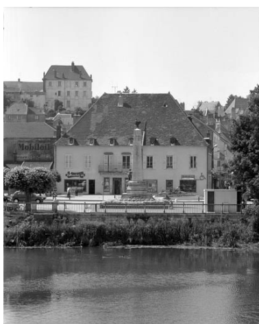
Place du Quatre Septembre aménagée en 1846, vue éloignée. Phot. Yves Sancey IVR43_19917000271X
