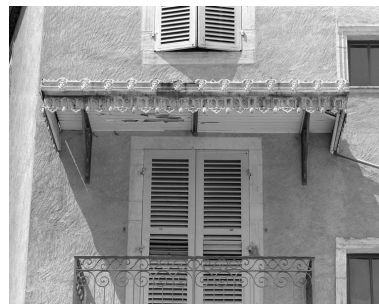
Place de la Petite Fontaine : détail de l'auvent du balcon de l'édifice droit. Phot. Yves Sancey IVR43_19897000302X
