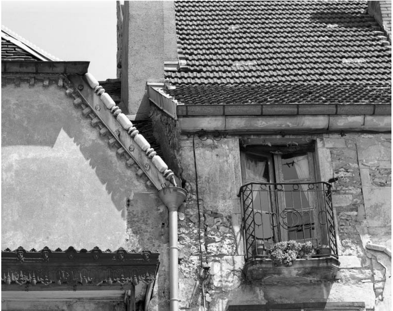
Place de la Petite Fontaine : détail des toitures et balcon des édifices formant le fond de la place.
