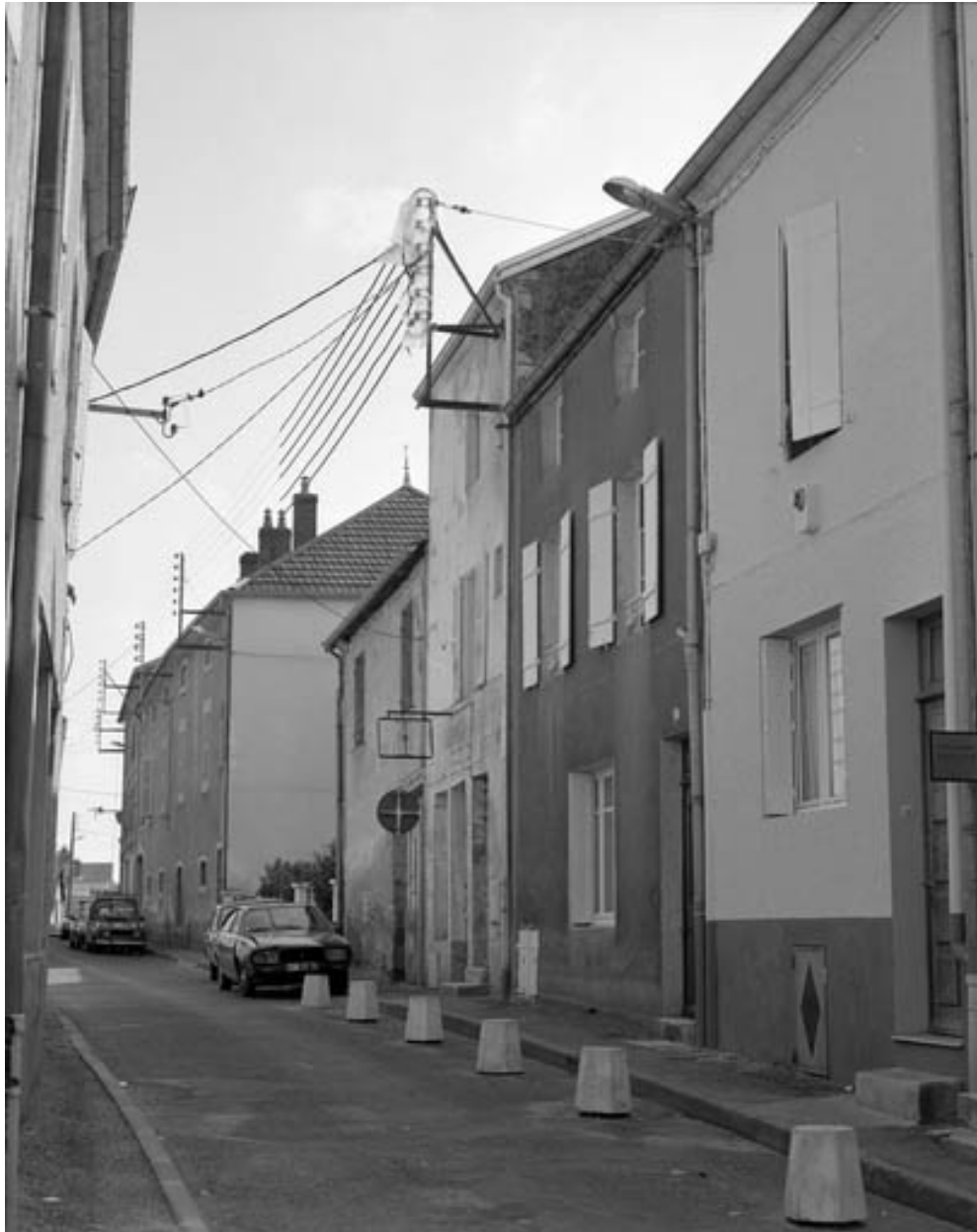
Vue de la rue de Belfort.
