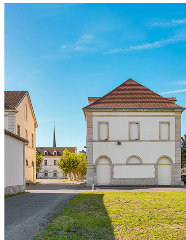
Les casernes dévolues à la cavalerie. Phot. Thierry Kuntz IVR26_20232100210NUC4A
