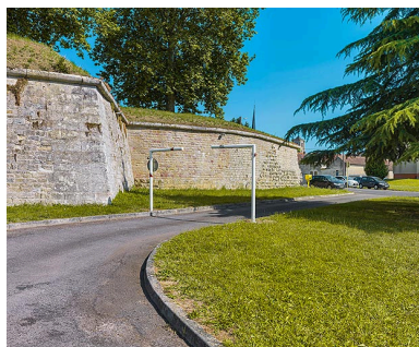
Vestige de l'ancienne tour du "Béchet". Phot. Thierry Kuntz IVR26_20232100180NUC4A
