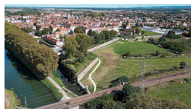
Vue aérienne du front sud. Phot. Sébastien Bardou IVR26_20232100442NUC2A
