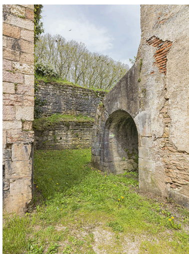
Galerie voûtée adossée à la caserne ouest du château. Phot. Thierry Kuntz IVR26_20242100236NUC4A
