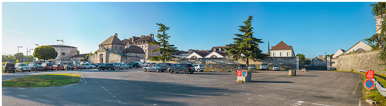
Le front nord de la place. De gauche à droite : la tour du Cygne, la porte Royale et le bastion Royal.
