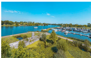
Vue depuis le terre-plein du bastion du Béchaux. Phot. Thierry Kuntz IVR26_20232100512NUC4A
