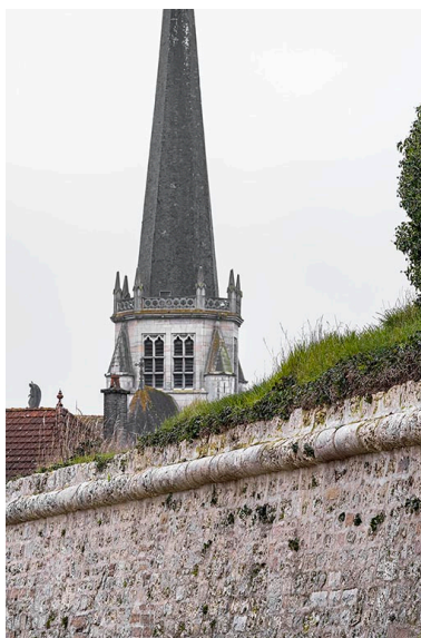
Détail d'un rempart et clocher de l'église. Phot. Thierry Kuntz IVR26_20242100104NUC4A
