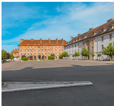
Les casernes d'infanterie construites vers 1760. Phot. Thierry Kuntz IVR26_20232100193NUC4A
