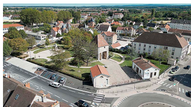
Vue aérienne de la porte de Comté. Phot. Sébastien Bardou IVR26_20232100443NUC2A
