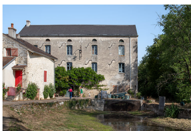
L'ensemble du moulin depuis la Cure. Phot. Nicolas Waltefaugle IVR26_20268900370NUC4A
