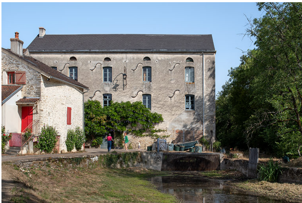
L'ensemble du moulin depuis la Cure.
