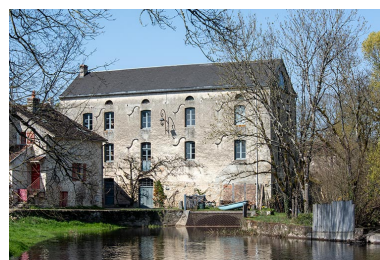
L'ensemble du moulin depuis la Cure. Phot. Nicolas Waltefaugle IVR26_20268900107NUC4A
