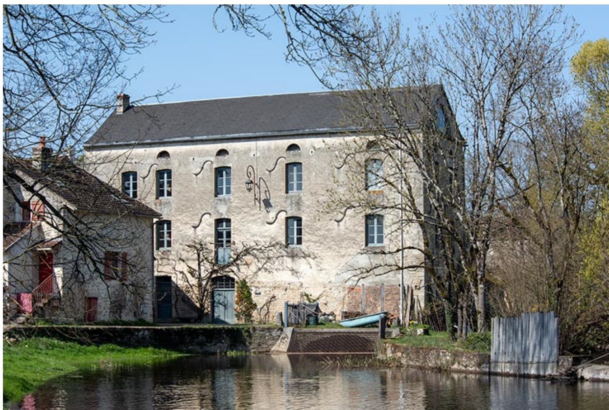
L'ensemble du moulin depuis la Cure.
