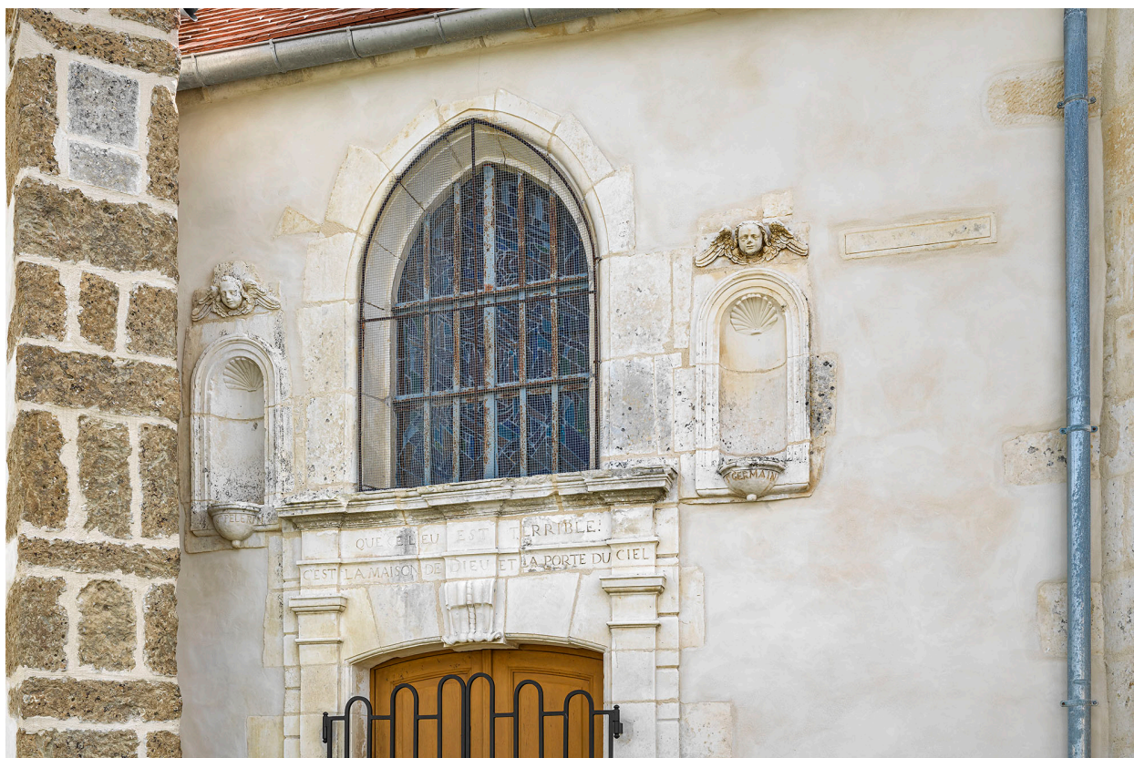
Elévation nord : détail du portail et de la baie éclairant le transept.
