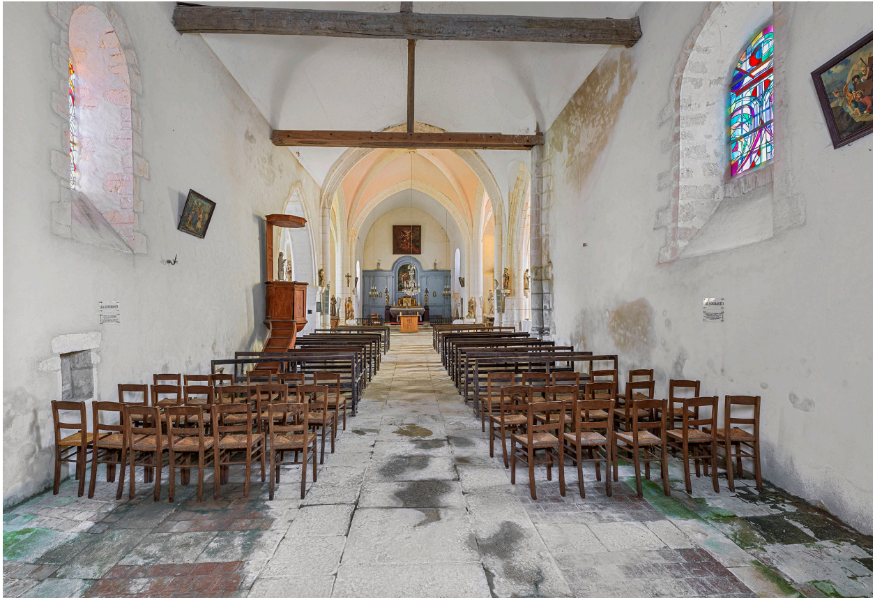
Vue d'ensemble de l'intérieur de l'église depuis la deuxième travée de la nef.
