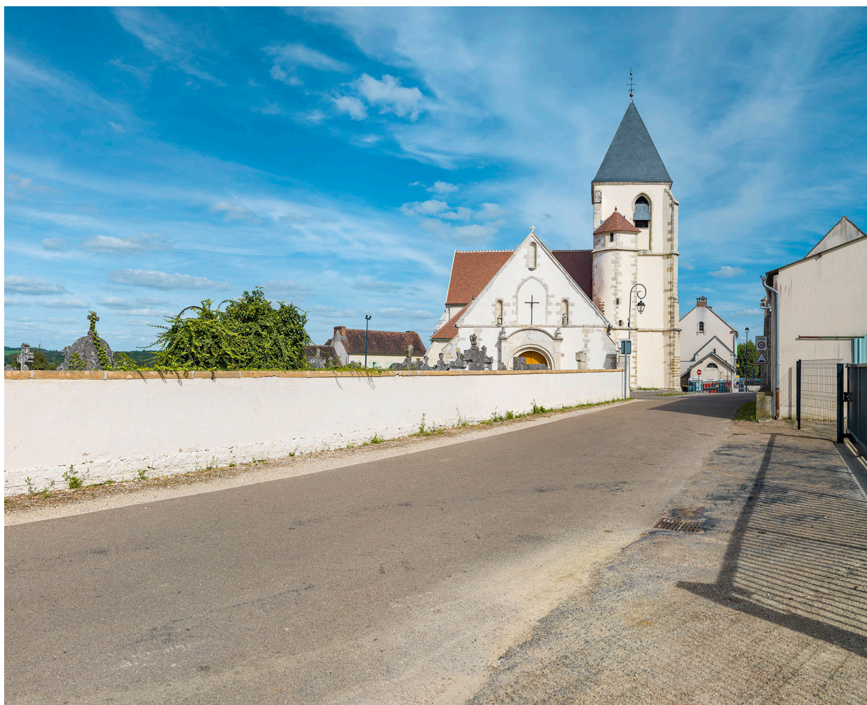
Vue d'ensemble de la façade principale et du clocher.
