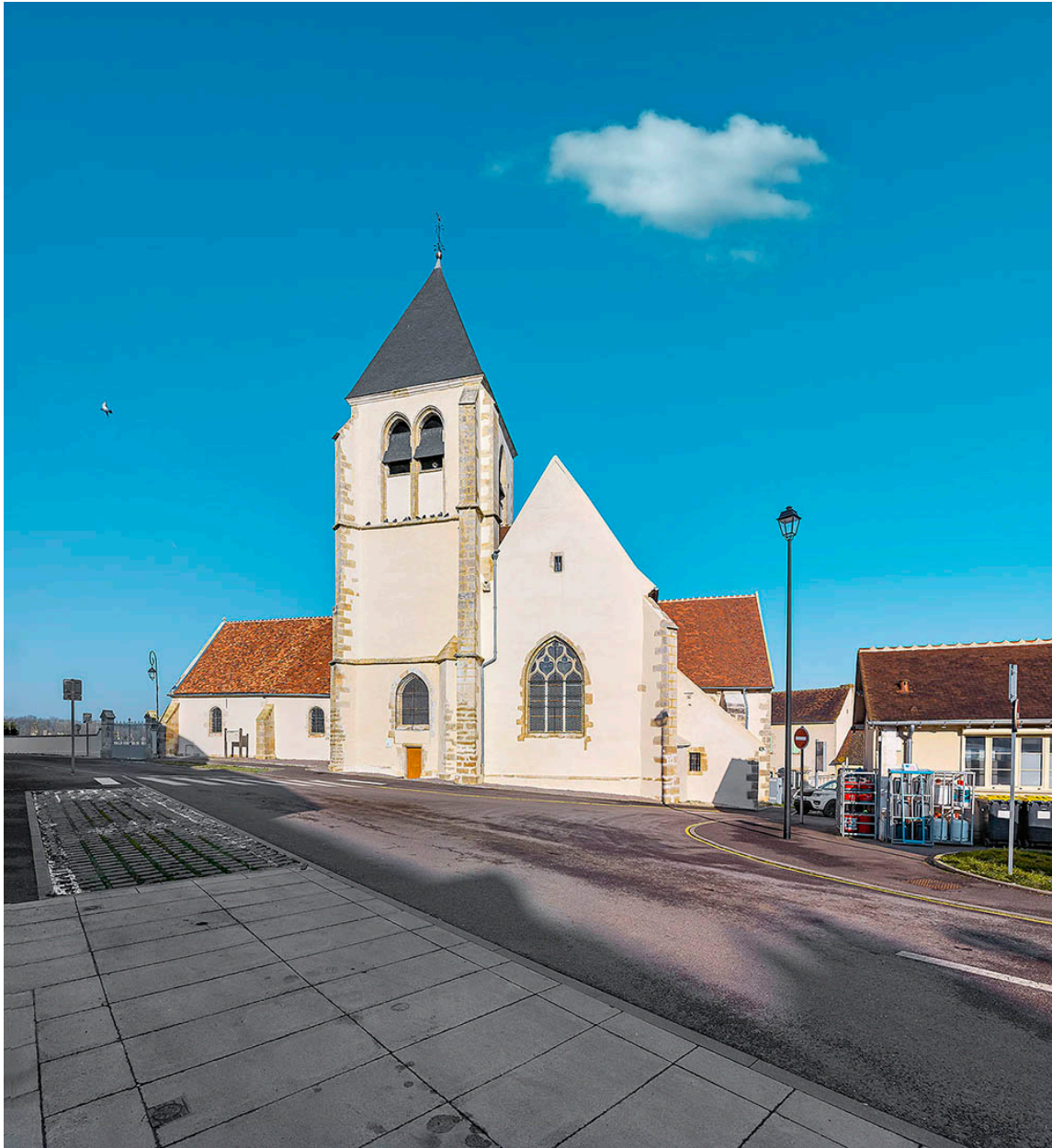
Elévation sud avec clocher.
