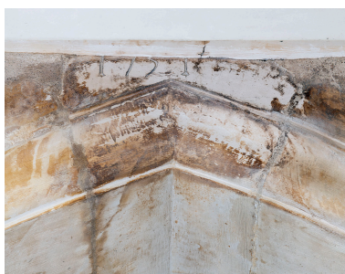
Arc brisé du transept nord : date (1751). Phot. Thierry Kuntz IVR26_20248900275NUC4A
