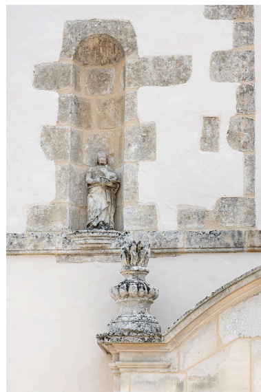
Détail de la façade principale : niche et pot à feu. Phot. Thierry Kuntz IVR26_20248900224NUC4A
