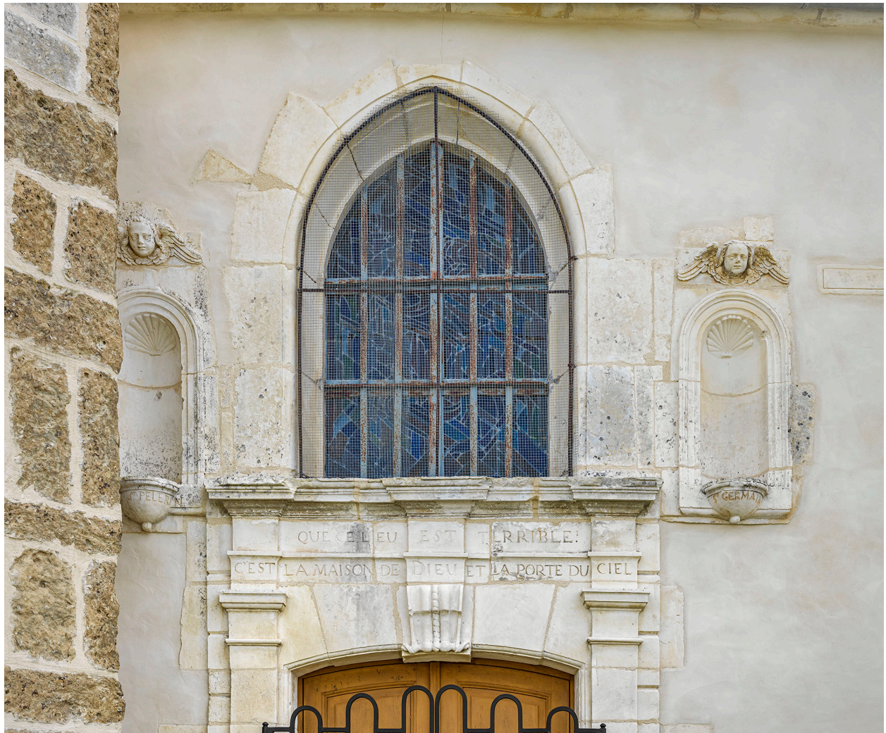
Elévation nord : détail du portail et de la baie éclairant le transept.
