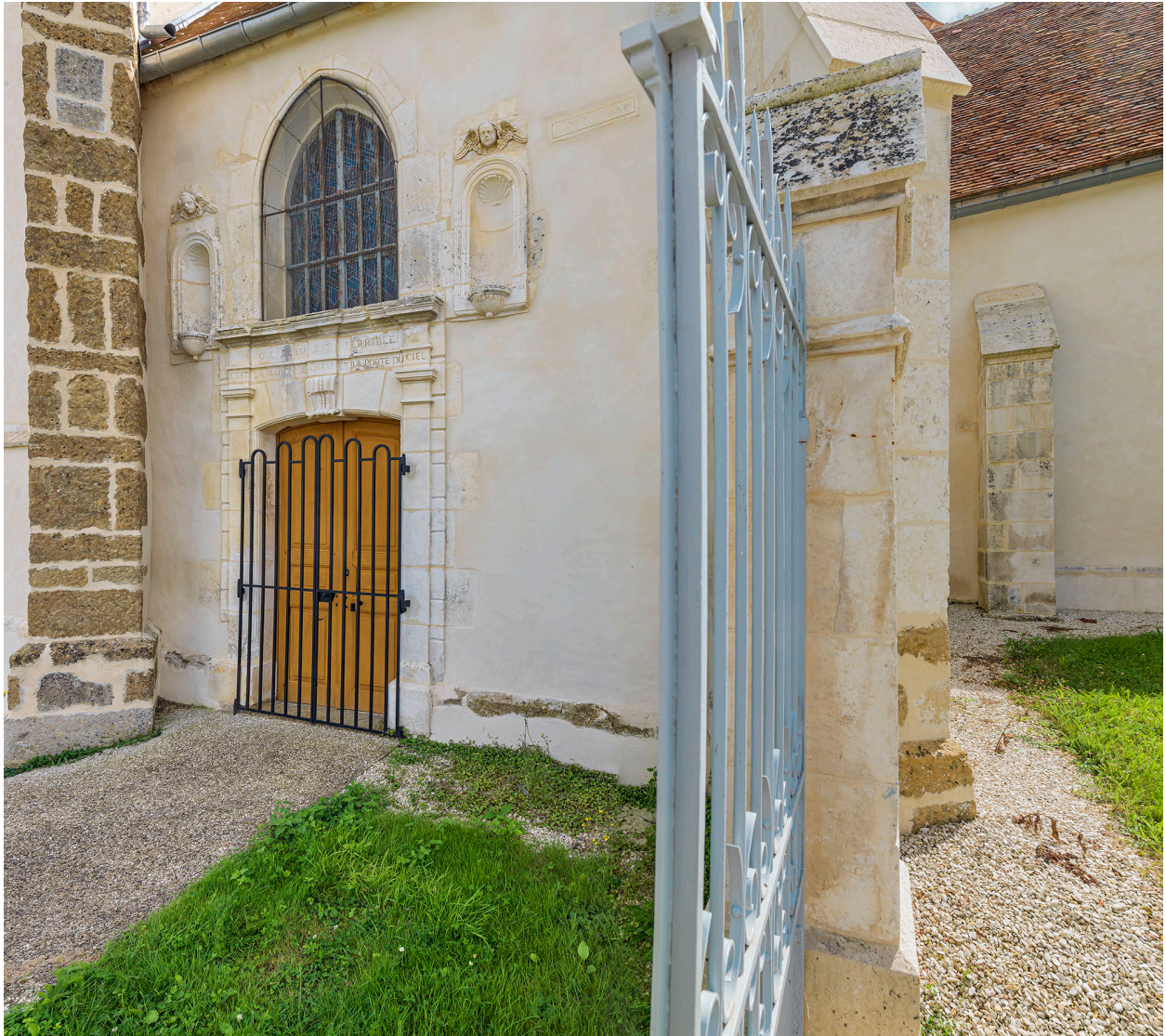
Élévation nord : jonction entre la nef et le transept.
