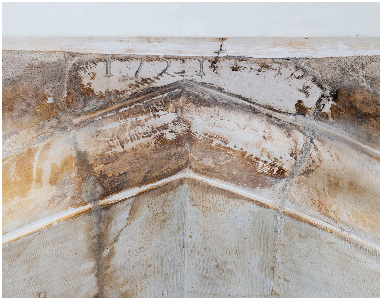
Arc brisé du transept nord : date (1751).
