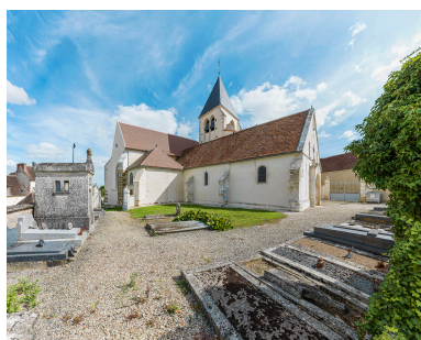
Vue d'ensemble de l'élevation nord, depuis le cimetière. Phot. Thierry Kuntz IVR26_20248900219NUC4A
