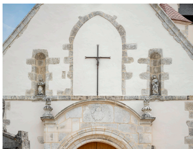
Détail de la façade principale et du portail. Phot. Thierry Kuntz IVR26_20248900222NUC4A
