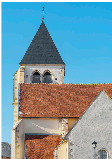
Détail de la toiture restaurée : vue depuis le chevet plat. Phot. Thierry Kuntz IVR26_20248900003NUC4A
