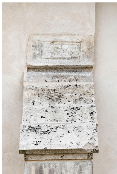
Contrefort en pierre de taille sur le mur nord de la nef surmonté d'un cartouche portant une inscription (dédicace ?). Phot. Thierry Kuntz IVR26_20248900235NUC4A
