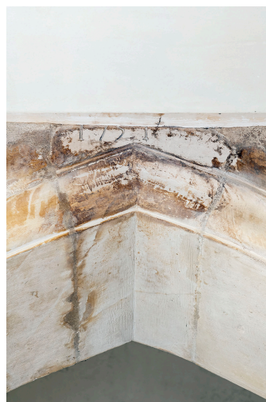
Arc brisé du transept nord : date (1751). Phot. Thierry Kuntz IVR26_20248900276NUC4A
