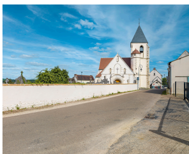
Vue d'ensemble de la façade principale et du clocher. Phot. Thierry Kuntz IVR26_20248900221NUC4A
