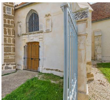
Elévation nord : jonction entre la nef et le transept. Phot. Thierry Kuntz IVR26_20248900236NUC4A
