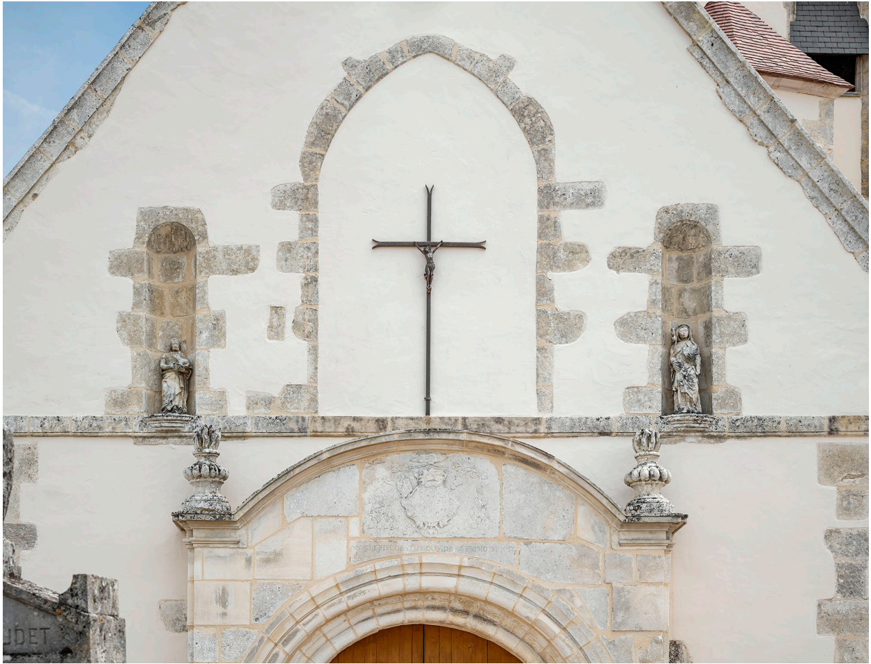
Détail de la façade principale et du portail.
