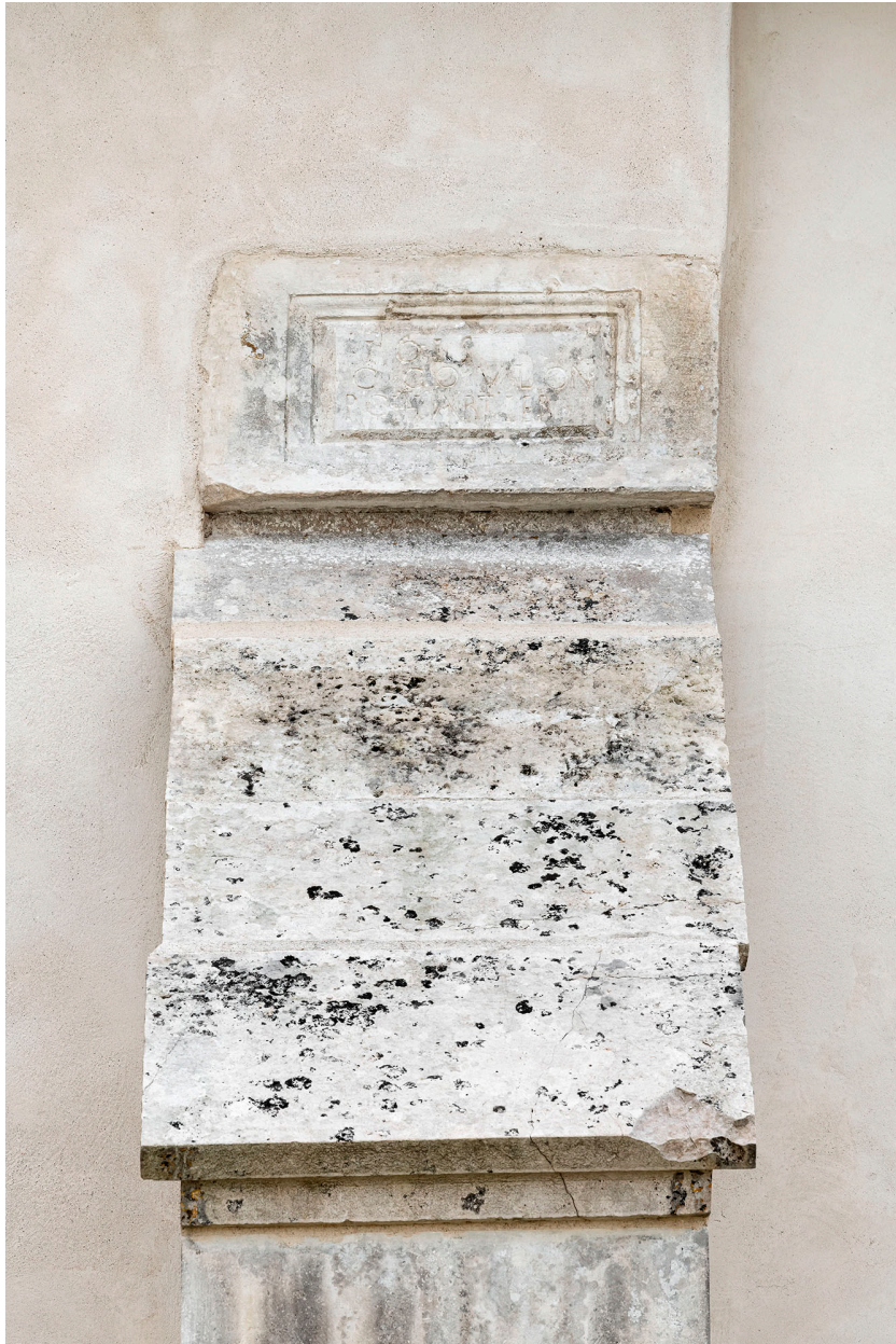
Contrefort en pierre de taille sur le mur nord de la nef surmonté d'un cartouche portant une inscription (dédicace ?).
