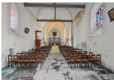
Vue d'ensemble de l'intérieur de l'église depuis la deuxième travée de la nef.
