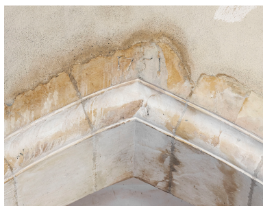
Arc brisé du transept nord : date (1751). Phot. Thierry Kuntz IVR26_20248900293NUC4A
