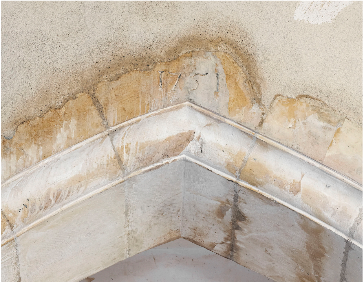
Arc brisé du transept nord : date (1751).
