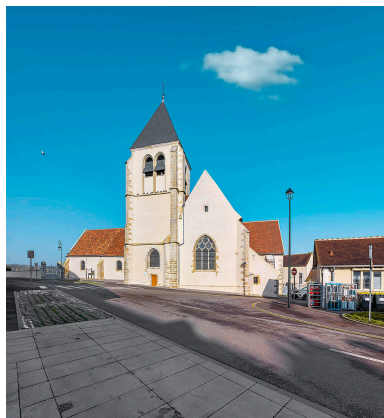
Elévation sud avec clocher. Phot. Thierry Kuntz IVR26_20248900002NUC4A
