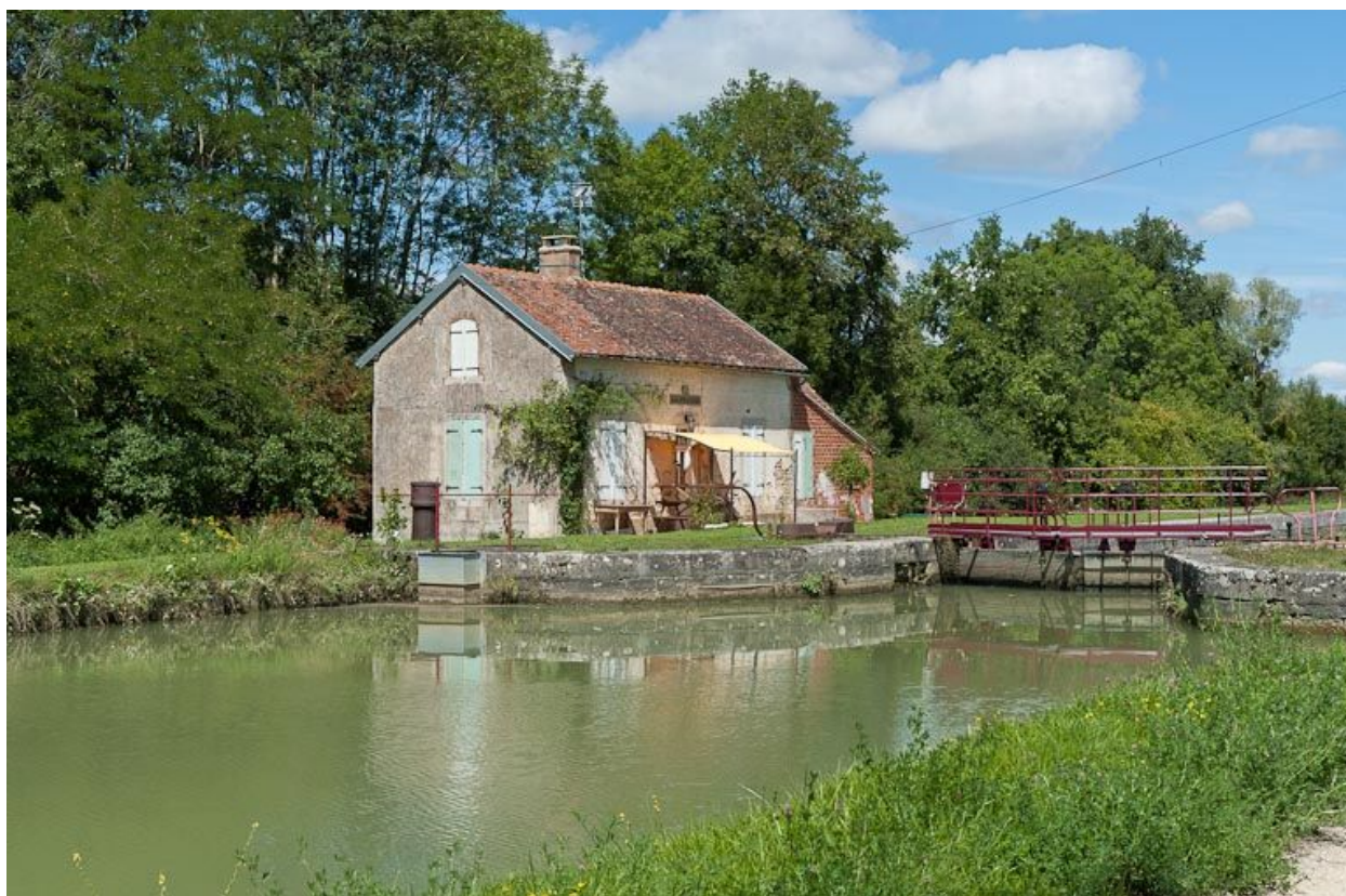
Vue du site d'écluse depuis l'amont.
