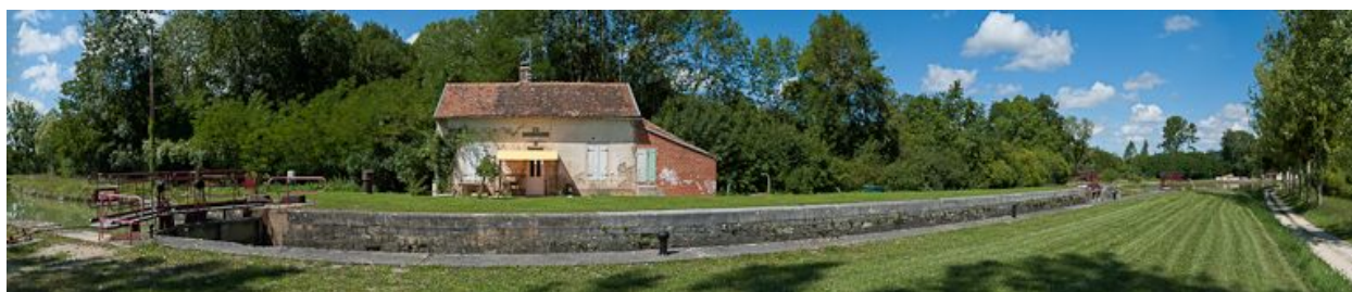
Vue d'ensemble du site d'écluse.
