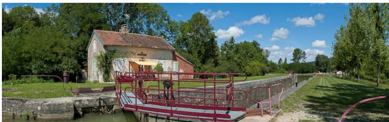
Vue d'ensemble du site d'écluse.
