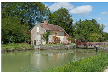
Vue du site d'écluse depuis l'amont. Phot. Pierre-Marie Barbe-Richaud IVR26_20112103816NUC4AQ
