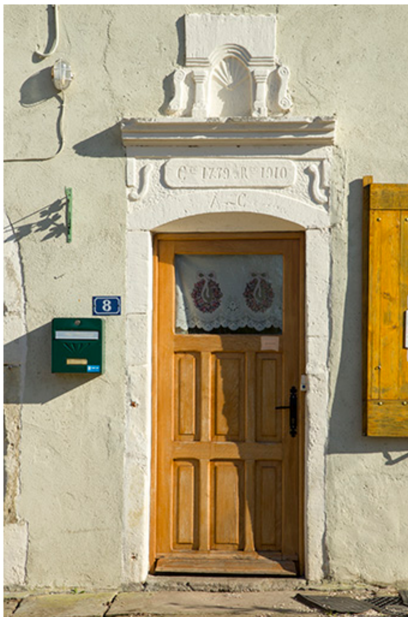
Détail d'une porte, rue Royale.
