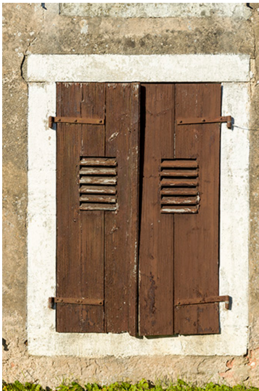
Détail d'une baie avec ses volets.
