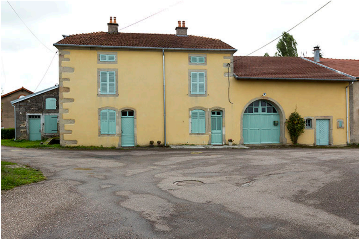
Ferme, rue de la Pompe.
