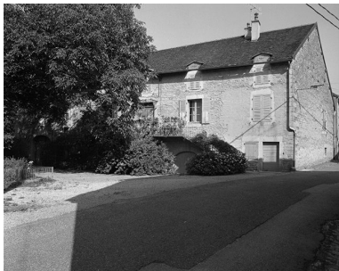
Ferme de vigneron située impasse de la Bourcette. Phot. Yves Sancey IVR43_19843900190X
