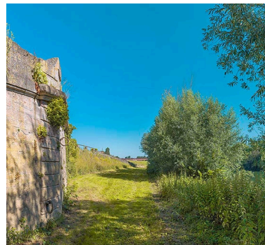
Les quais, en direction du pont de Bragny. Phot. Thierry Kuntz IVR26_20207100209NUC4A
