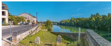
Quais de Verdun : la double rampe. Phot. Thierry Kuntz IVR26_20207100207NUC4A
