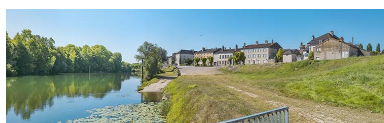
Quais et port, avec rampe d'accès, vus d'aval. Phot. Thierry Kuntz IVR26_20207100216NUC4A
