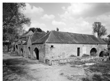
Bâtiment de la fenderie, vue prise du sud-est. Phot. Jean-Luc Duthu IVR26_19932100900V
