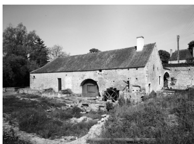
Bâtiment de la fenderie, élévation est. Phot. Jean-Luc Duthu IVR26_19932100898V
