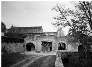
Elévation sud de l'usine prise de la rampe d'accès. Phot. Jean-Luc Duthu IVR26_19932100904V
