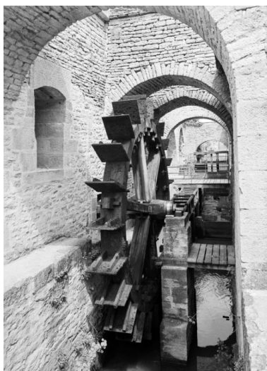
Haut fourneau, roue hydraulique reconstituée. Phot. Jean-Luc Duthu IVR26_19932100908V
