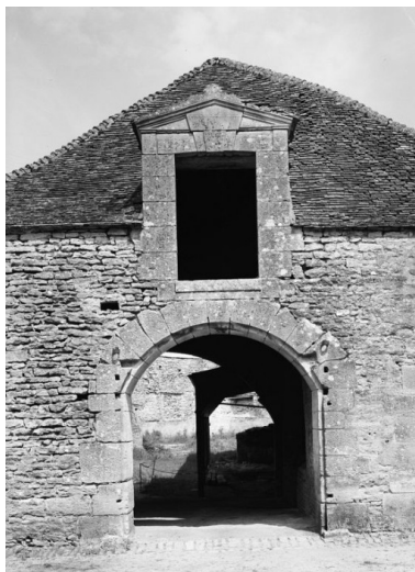
Entrée du bâtiment de la forge d'affinerie, élévation sud. Phot. Jean-Luc Duthu IVR26_19932100906V
