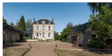
Façade sur le jardin. Phot. Pierre-Marie Barbe-Richaud IVR26_20205800530NUC4AQ
