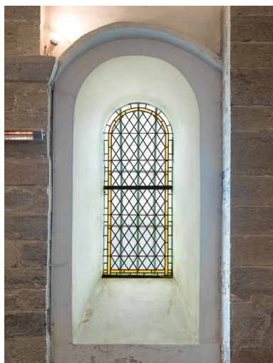
Vue d'ensemble, verrière de la nef. Phot. Pierre-Marie Barbe-Richaud IVR26_20162100089NUC2A
