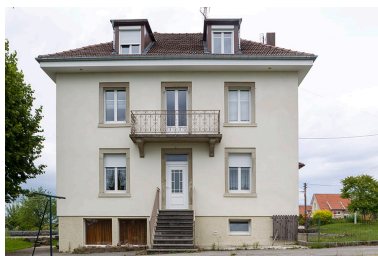
Logement patronal : façade latérale droite. Phot. Sonia Dourlot IVR43_20152500890NUC2A
