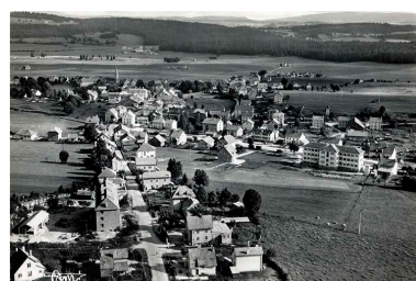
Charquemont (Doubs). 11058 - Vue générale aérienne, entre 1951 et 1958. Autr. auteur inconnu IVR43_20132500075NUC1A
