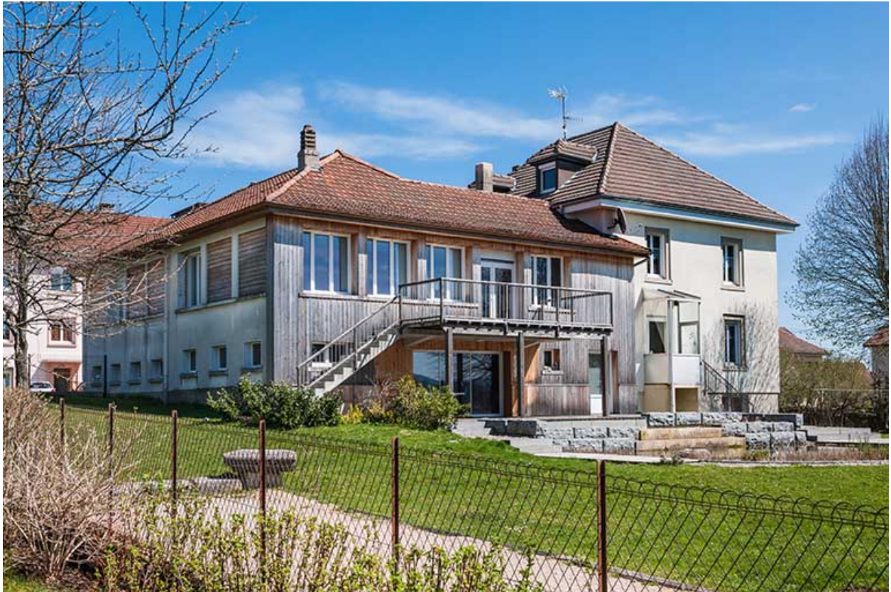
Usine : façades postérieure et latérale droite.
