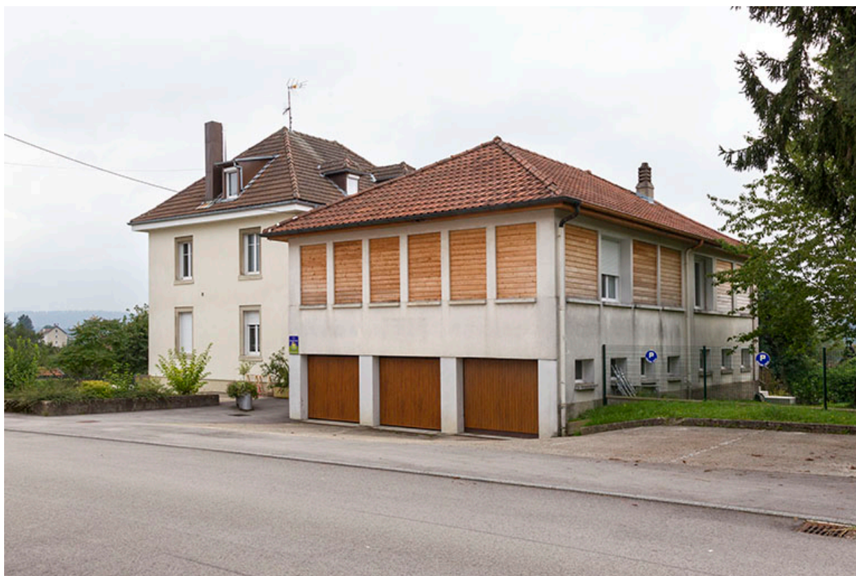
Usine : façades antérieure et latérale droite.
