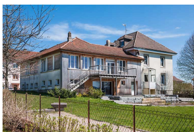
Usine : façades postérieure et latérale droite. Phot. Jérôme Mongreville IVR43_20142500212NUC4A
