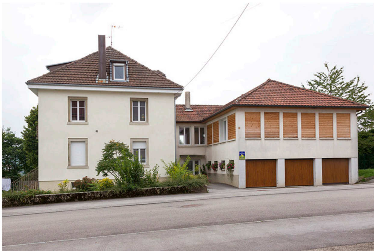
Logement patronal et usine : façades antérieures, sur la rue Victor Hugo.
