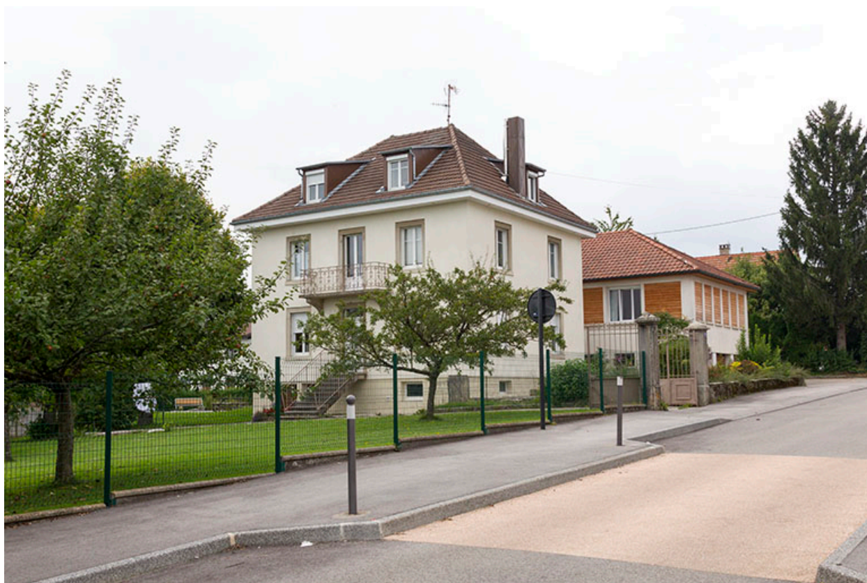
Vue d'ensemble du site, depuis l'est.
