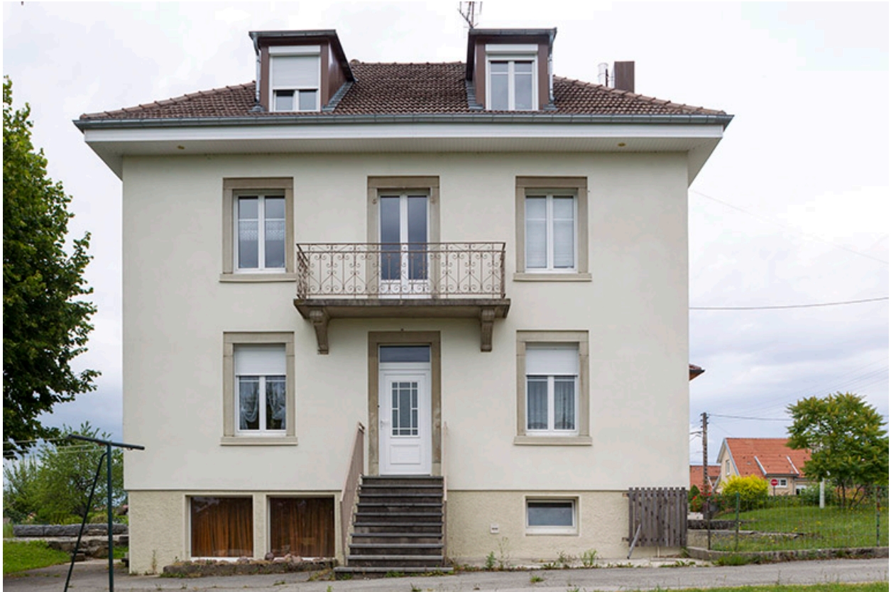
Logement patronal : façade latérale droite.
