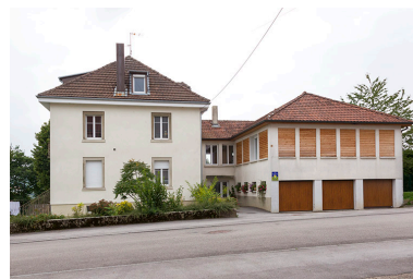
Logement patronal et usine : façades antérieures, sur la rue Victor Hugo. Phot. Yves Sancey IVR43_20132503028NUC2A
