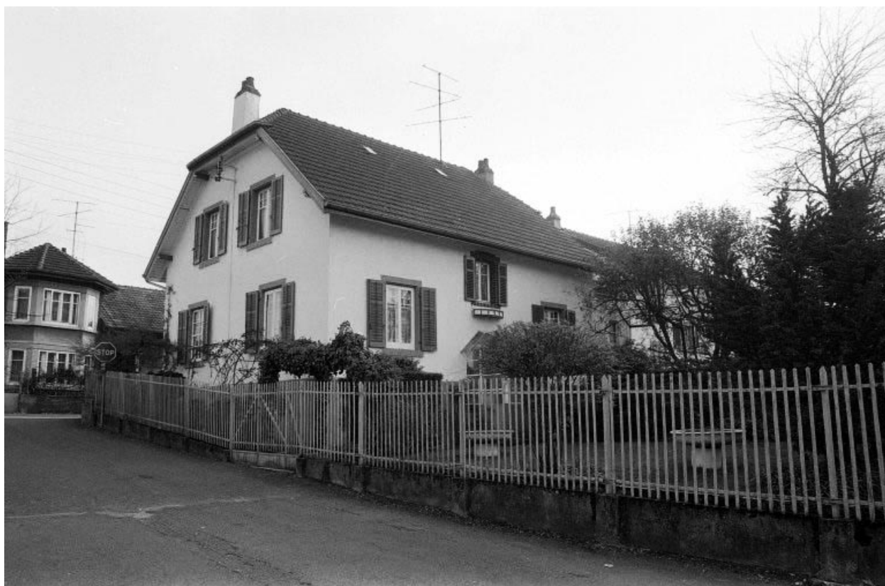
Façades postérieure et latérale droite.
