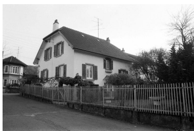
Façades postérieure et latérale droite.
