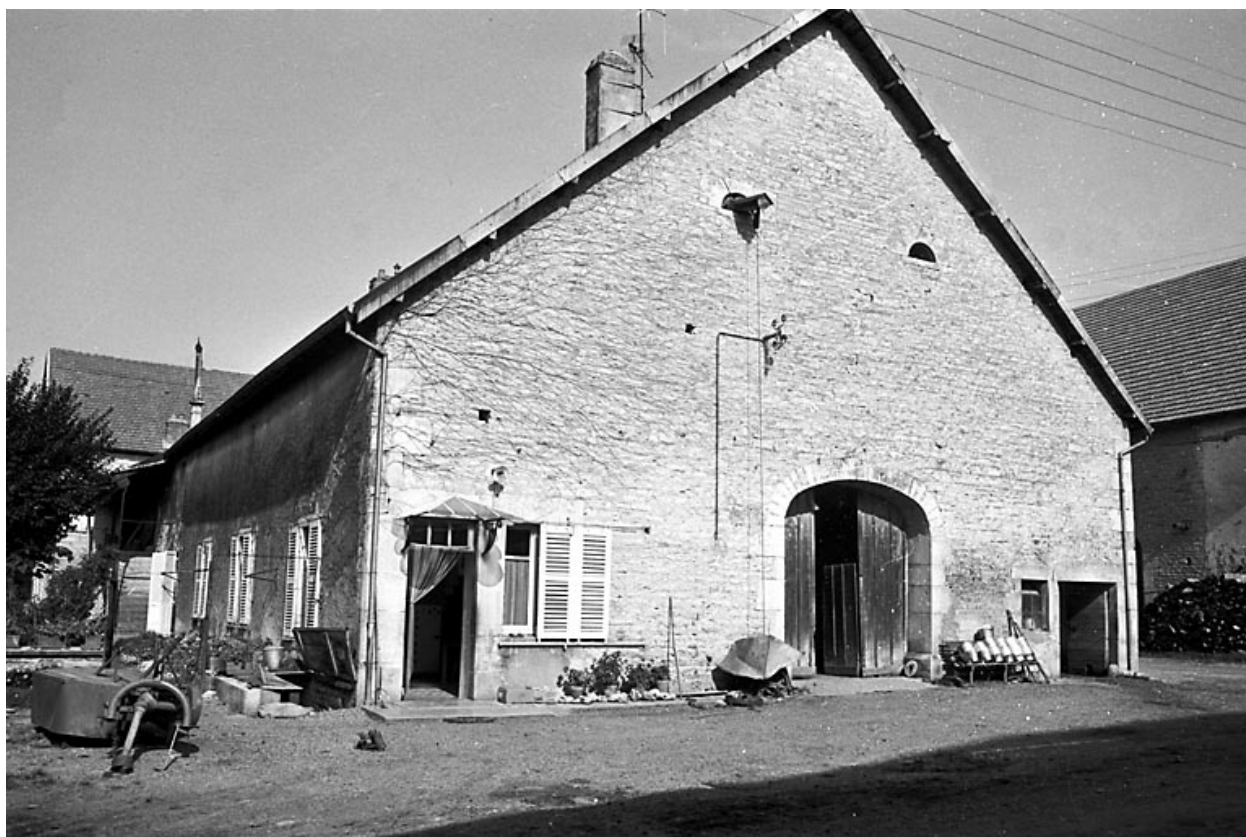
Ferme située 5 rue de Tarcenay.
