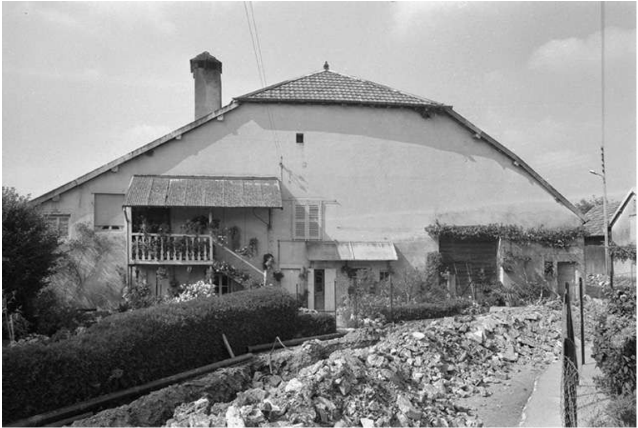
Ferme située route de Naglans.
