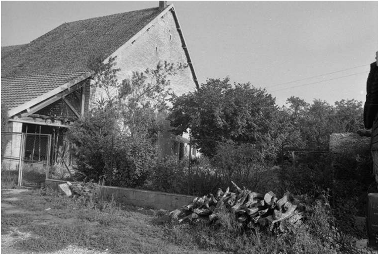
Ferme située 12 rue de Merrey. La partie gauche correspondant à l'avant-toit a été détruite après 1976.
