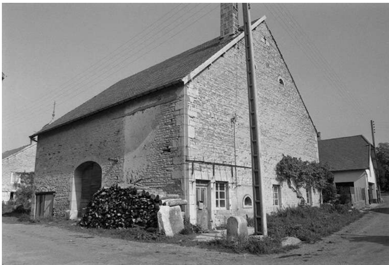
Ferme située 7 rue de Tarcenay.
