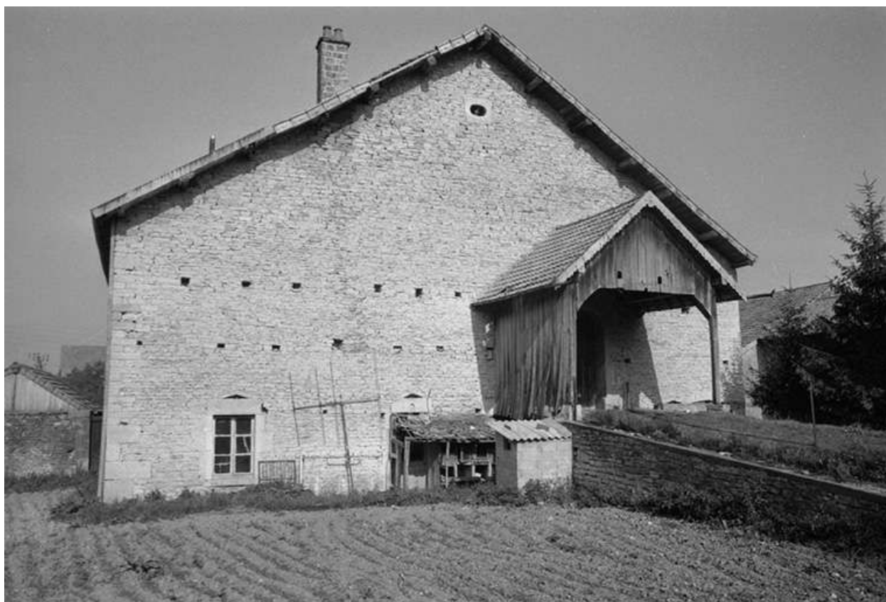
Ferme située 2 rue de Tarcenay.
