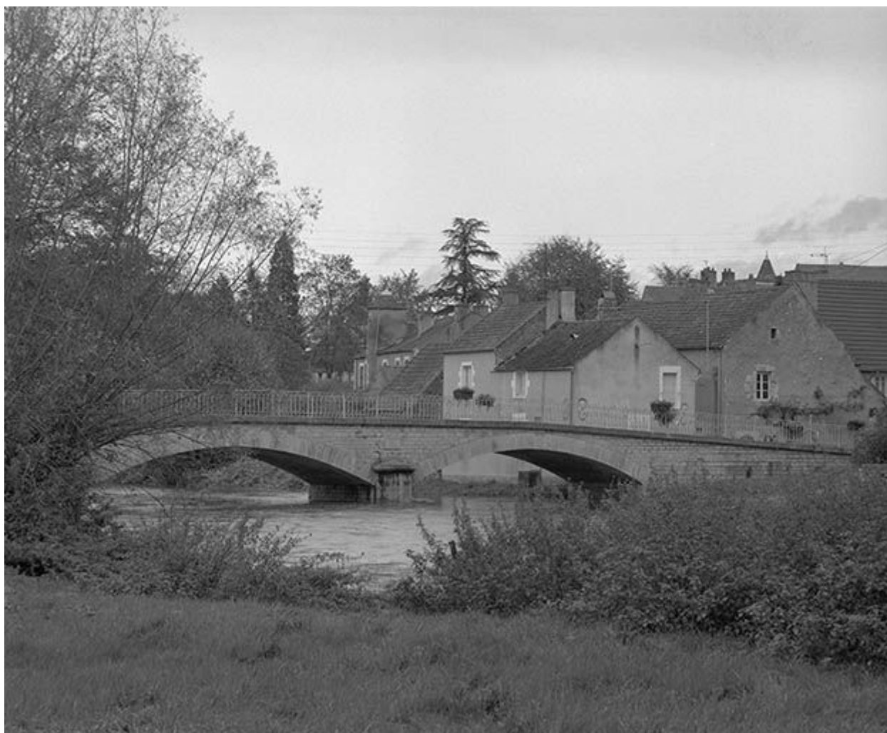
Vue d'ensemble prise de l'amont.
