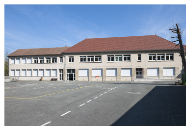
Ecole primaire. Phot. Jérôme Mongreville IVR43_20132500274NUC4A
