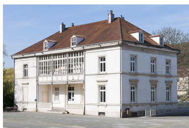
Façade est vue de trois quarts droite. Phot. Jérôme Mongreville IVR43_20132500270NUC4A
