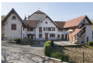
Dépendances (logement, remises et écuries). Phot. Jérôme Mongreville IVR43_20132500273NUC4A
