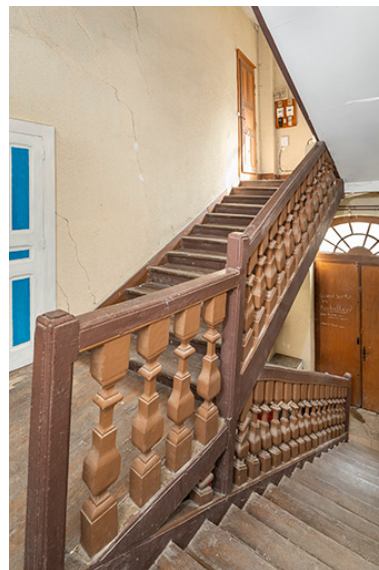
Escalier (n°3). Vue depuis l'entresol. Phot. Jérôme Mongreville IVR43_20233900089NUC4A
