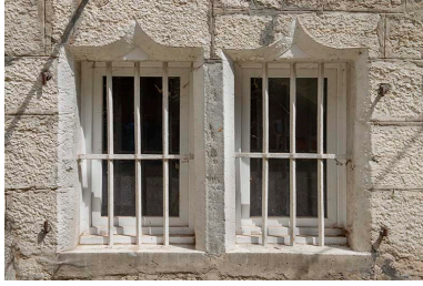
Façade est. Ouvertures du rez-de-chaussée. Phot. Jérôme Mongreville IVR43_20233900446NUC4A
