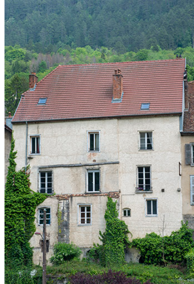
Façade ouest (n°3). Phot. Jérôme Mongreville IVR43_20233900451NUC4A
