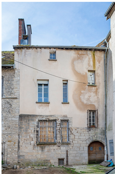
Façade nord (façade postérieure de l'hôtel de Falletans). Phot. Jérôme Mongreville IVR43_20233900085NUC4A
