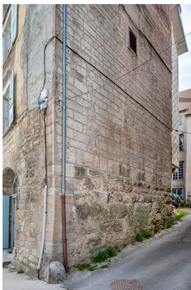
Mur nord d'accès à la cour. Phot. Jérôme Mongreville IVR43_20243900562NUC4A
