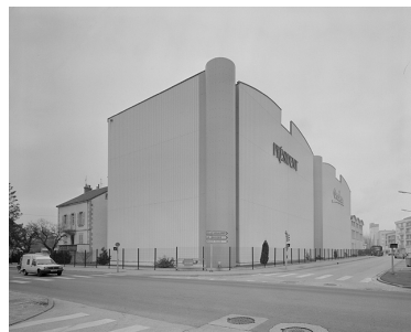
Magasin et entrepôt industriels. Phot. Jérôme Mongreville IVR43_19963901879V
