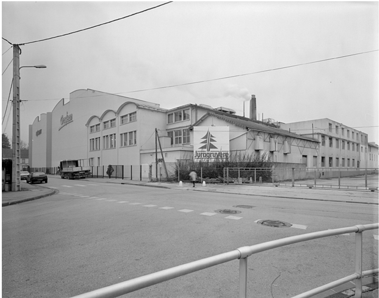
Vue d'ensemble depuis le nord-est. De gauche à droite : magasin et entrepôt industriels, atelier de fabrication et de conditionnement, chaufferie et vestiaire.
