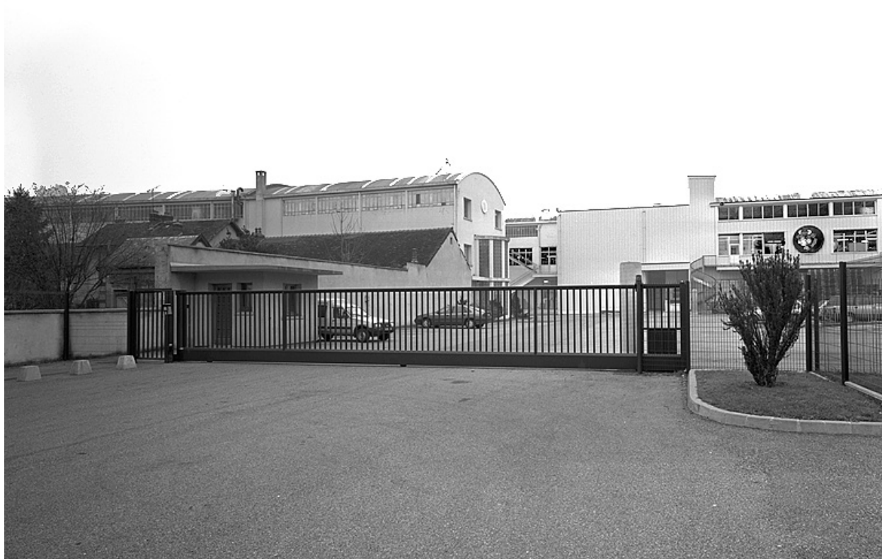
Vue d'ensemble depuis le sud.
