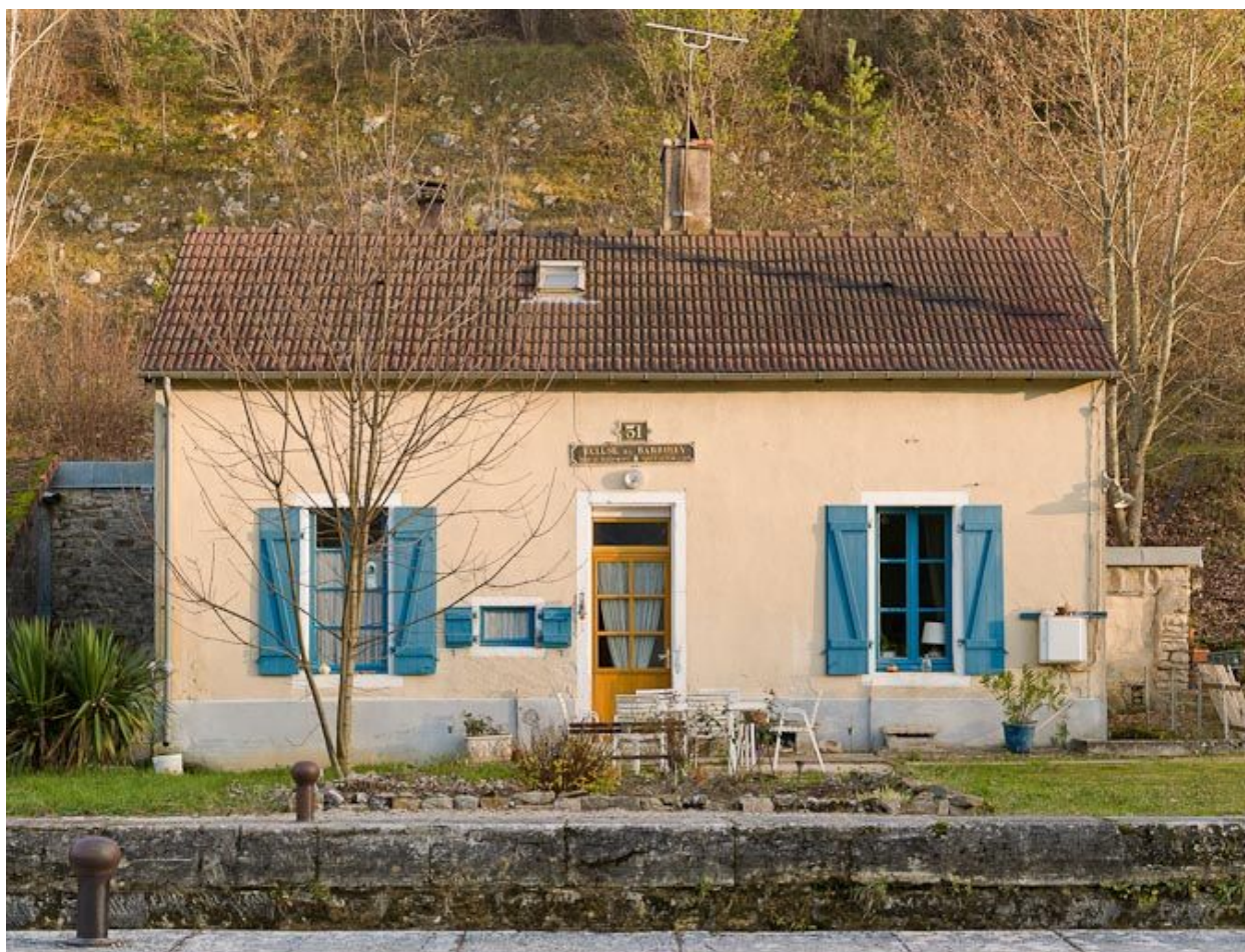
Vue de face de la maison éclusière.
