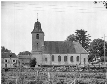
Face latérale droite. Phot. Yves Sancey IVR43_19757000135V
