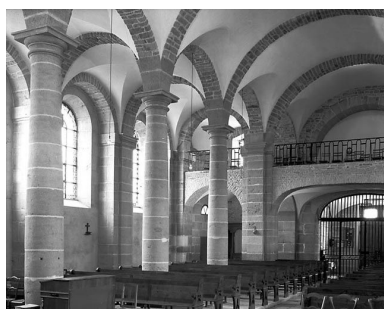
Vaisseau central et bas- côté droit vus du choeur. Phot. Yves Sancey IVR43_19757000136V
