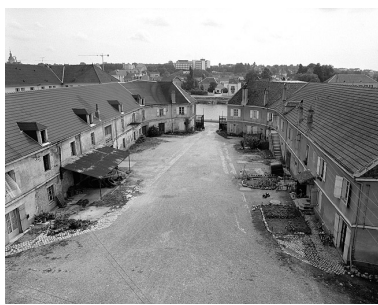
Vue d'ensemble des parties commerciales depuis l'habitation. Phot. Yves Sancey IVR43_19887000092X
