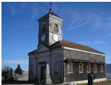
Eglise paroissiale de la Sainte-Trinité. Phot. Marie-Pierre Reynet IVR43_20083900459NUC1A
