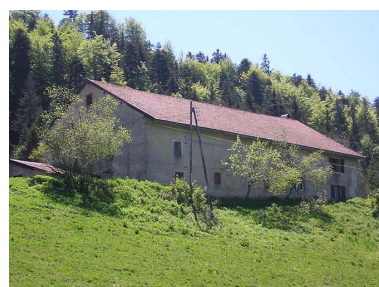
Ferme située au lieu-dit La Corne. Phot. Marie-Pierre Reynet IVR43_20083900501NUC1A
