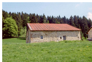
Façade postérieure. Phot. Yves Sancey IVR43_19993900134ZA
