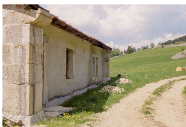
Façade antérieure vue de trois quarts. Phot. Yves Sancey IVR43_19993900138ZA
