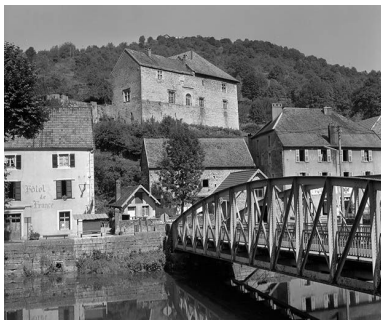
Maison forte dite Le Manoir, située à Lods Phot. Yves Sancey IVR43_19802500976X
