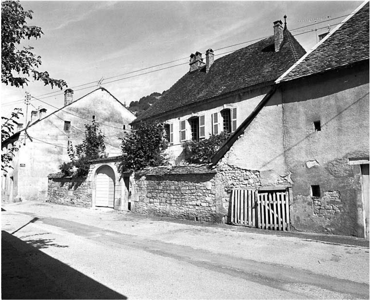
Maison de vigneron située à Vuillafans.
