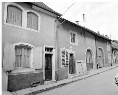
Maisons situées 9 à 13 rue des Martinets à Ornans. Phot. Yves Sancey IVR43_19772500098X
