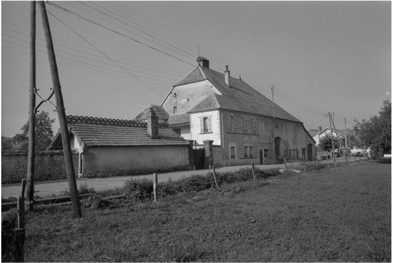
Ferme située à Villers-sous-Montrond.
