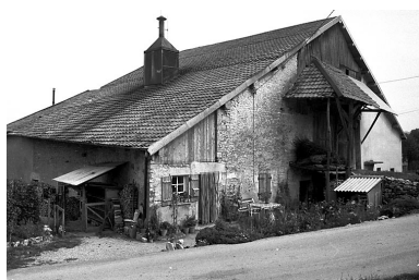
Trépot : exemple de ferme bloc à parallèles (habitation double) sur le mur pignon. Phot. Gilbert Poinot IVR43_19762500814Z
