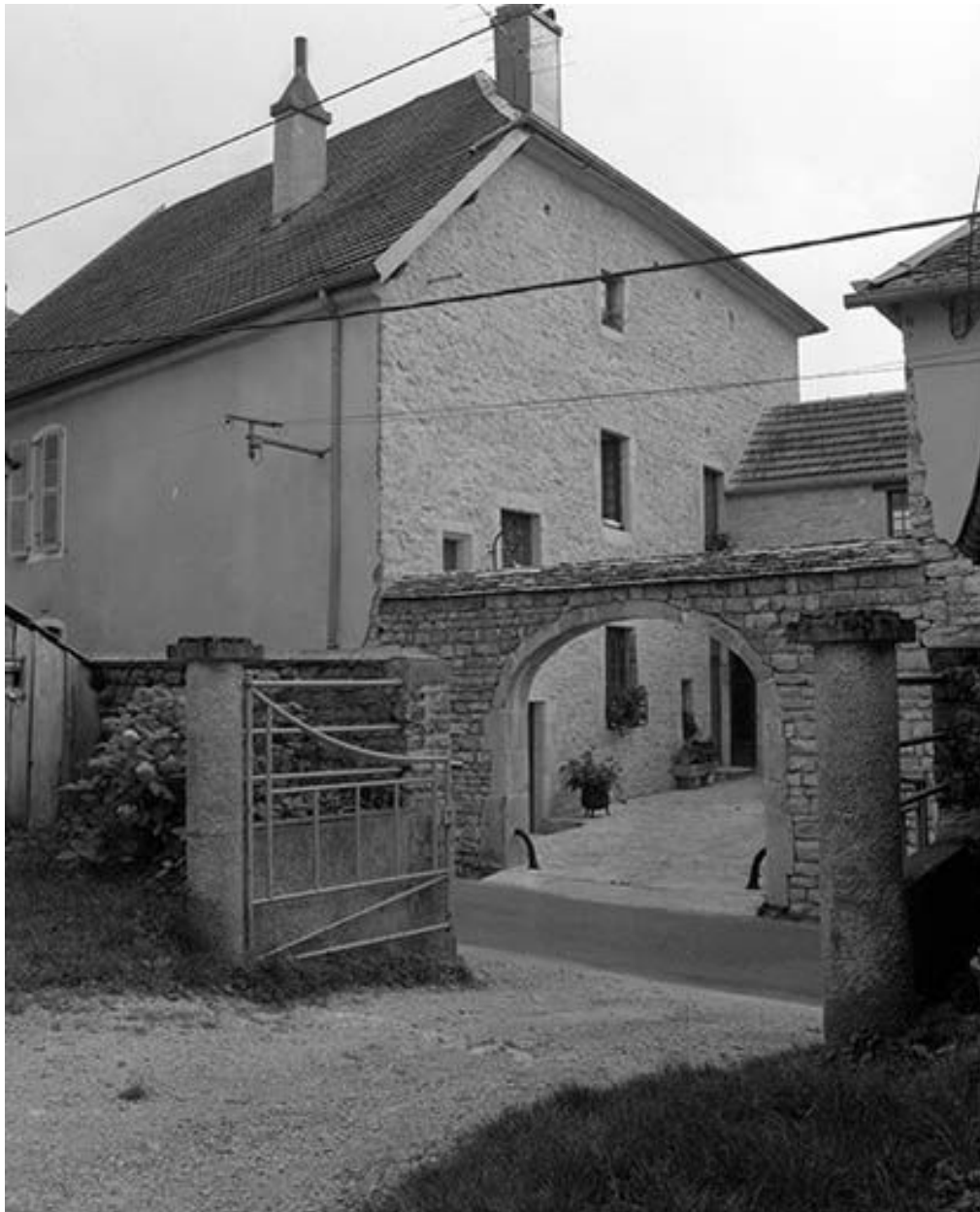
Maison de vigneron située à Vuillafans.
