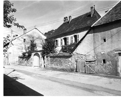
Maison de vigneron située à Vuillafans. Phot. Yves Sancey IVR43_19802501372X
