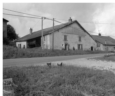
Ferme située à Saules. Phot. Yves Sancey IVR43_19802501134X
