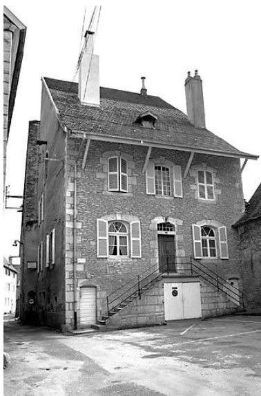
Maison située 4 rue de la Froidière à Ornans. Phot. Yves Sancey IVR43_19772500080X
