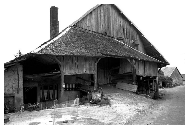
Ferme située à Trépot. Phot. Yves Sancey IVR43_19762500823Z
