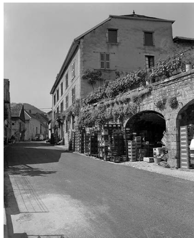
Maison de négociant en vin située à Lods Phot. Yves Sancey IVR43_19802500975X
