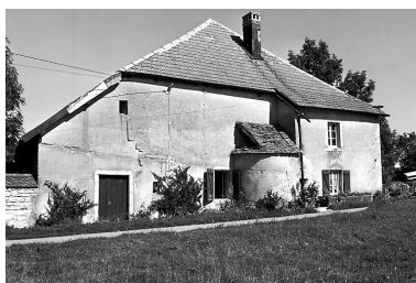
Ferme située à Echevannes. Phot. Yves Sancey IVR43_19802500935X
