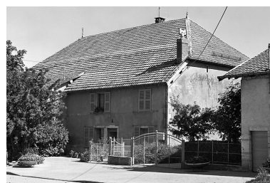
Ferme située à Voires. Phot. Yves Sancey IVR43_19802501073X
