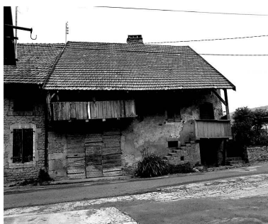
Ferme située 9 rue de l'Isle- aux-Prêtres à Ornans. Phot. Yves Sancey IVR43_19812500320X
