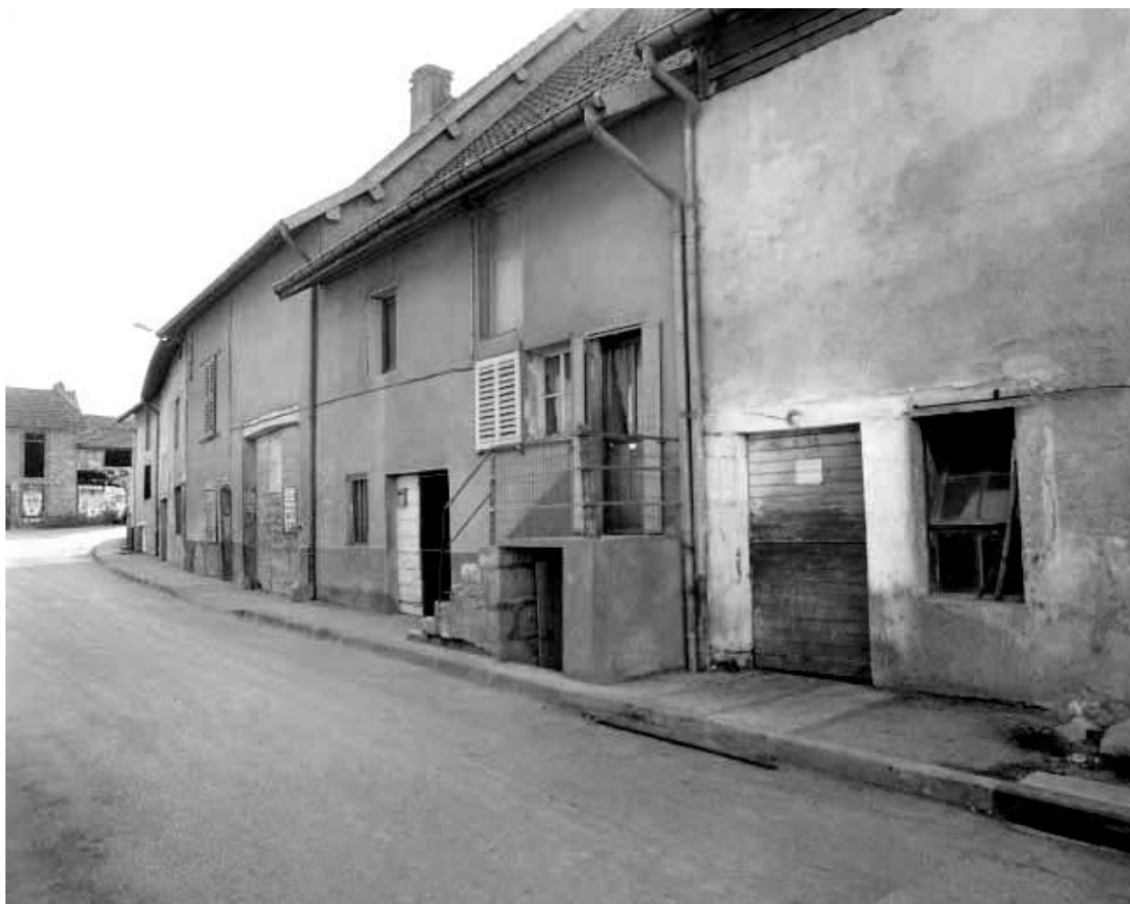
Maison de vigneron située 4 rue des Contrevaux à Ornans.
