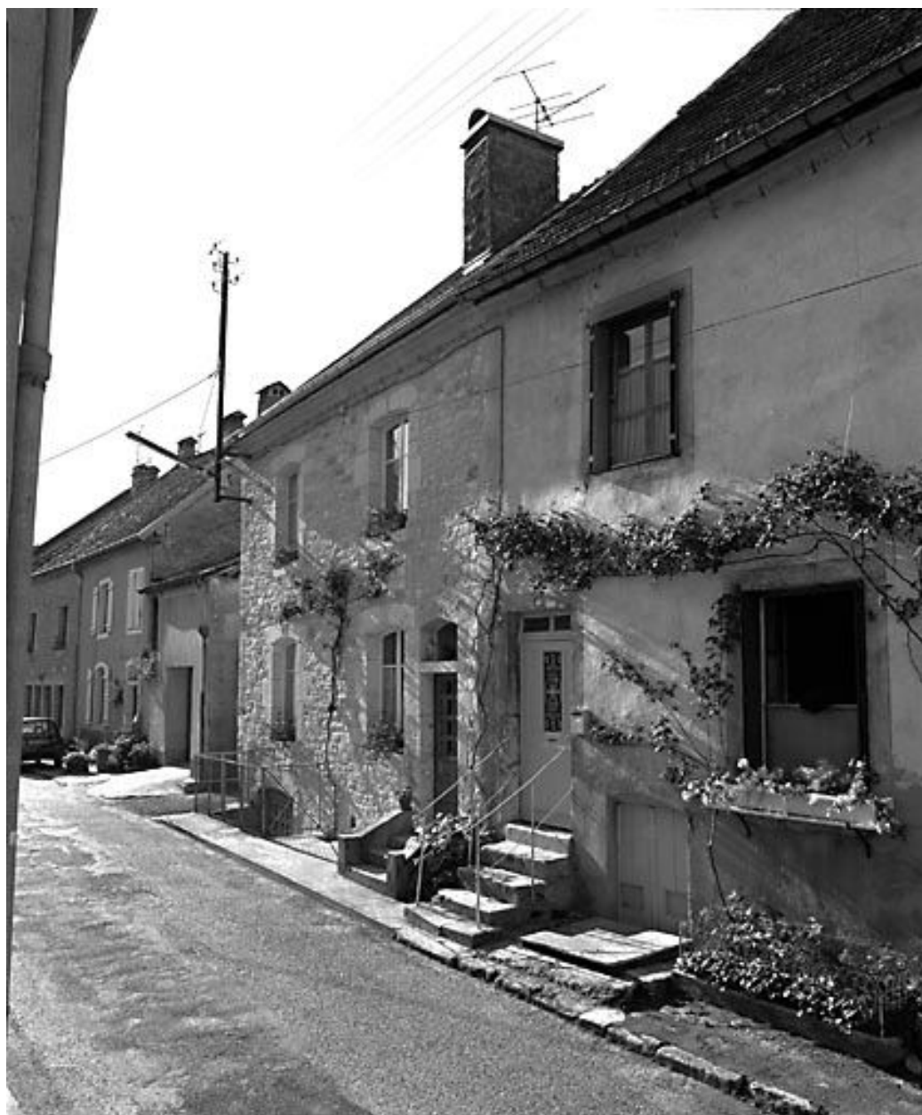
Maison de vigneron située à Vuillafans.
