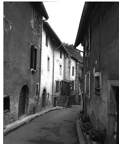
Maisons de vignerons situées à Lods Phot. Yves Sancey IVR43_19812500262X
