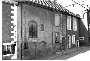
Maison de vigneron située à Mouthier-Haute-Pierre. Phot. Yves Sancey IVR43_19802501118X
