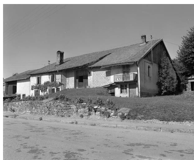
Ferme située à Guyans-Durnes. Phot. Yves Sancey IVR43_19802500939X
