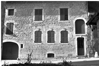
Maison de vigneron située à Mouthier-Haute-Pierre. Phot. Yves Sancey IVR43_19802501100X
