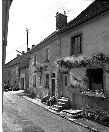
Maison de vigneron située à Vuillafans. Phot. Yves Sancey IVR43_19802501399X
