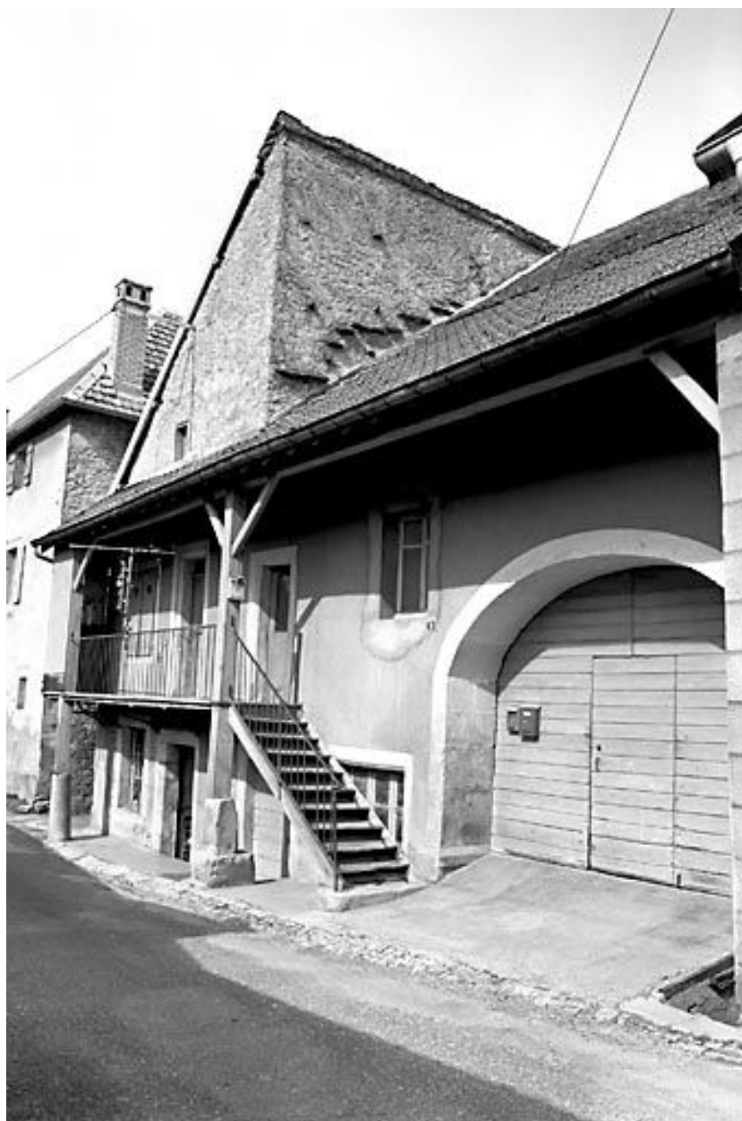
Maison de vigneron située 9 rue de la Froidière à Ornans.
