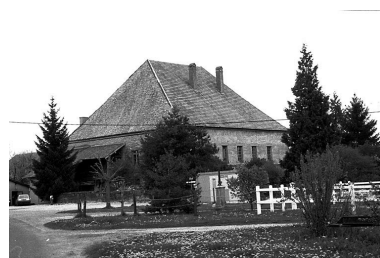
Maison dite Le Château située à Trépot. Phot. Liliane Hamelin IVR43_19982500113Z
