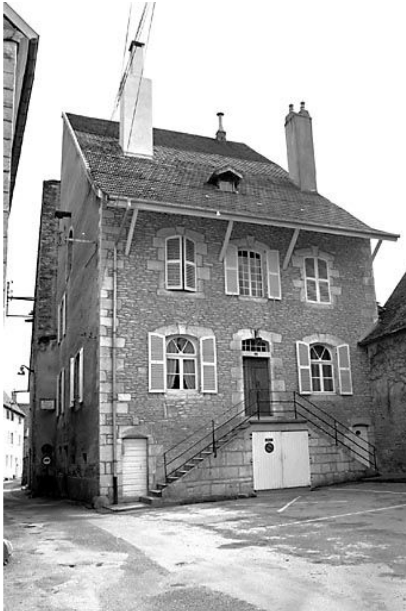
Maison située 4 rue de la Froidière à Ornans.
