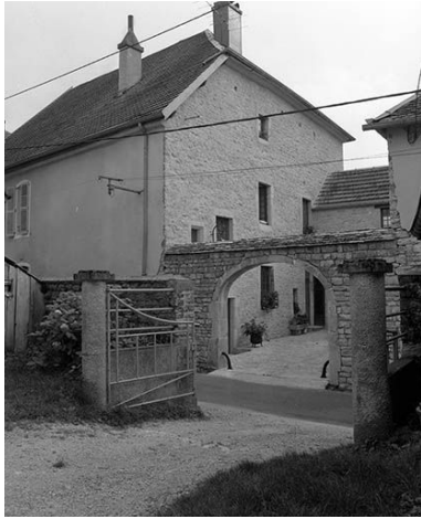
Maison de vigneron située à Vuillafans. Phot. Yves Sancey IVR43_19802501386X
