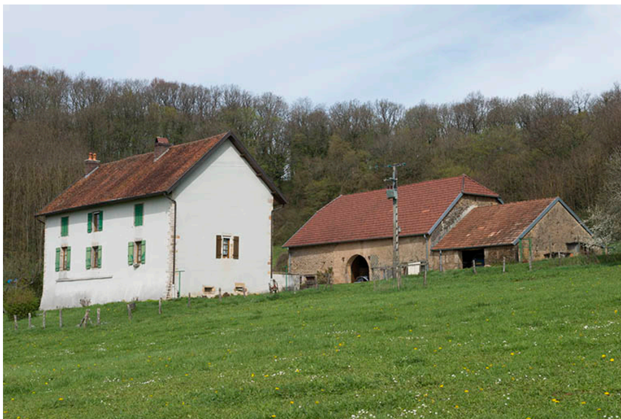
Vue générale des bâtiments composant le site.
