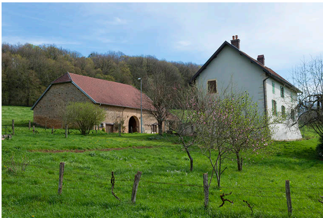
Vue depuis l'ouest.
