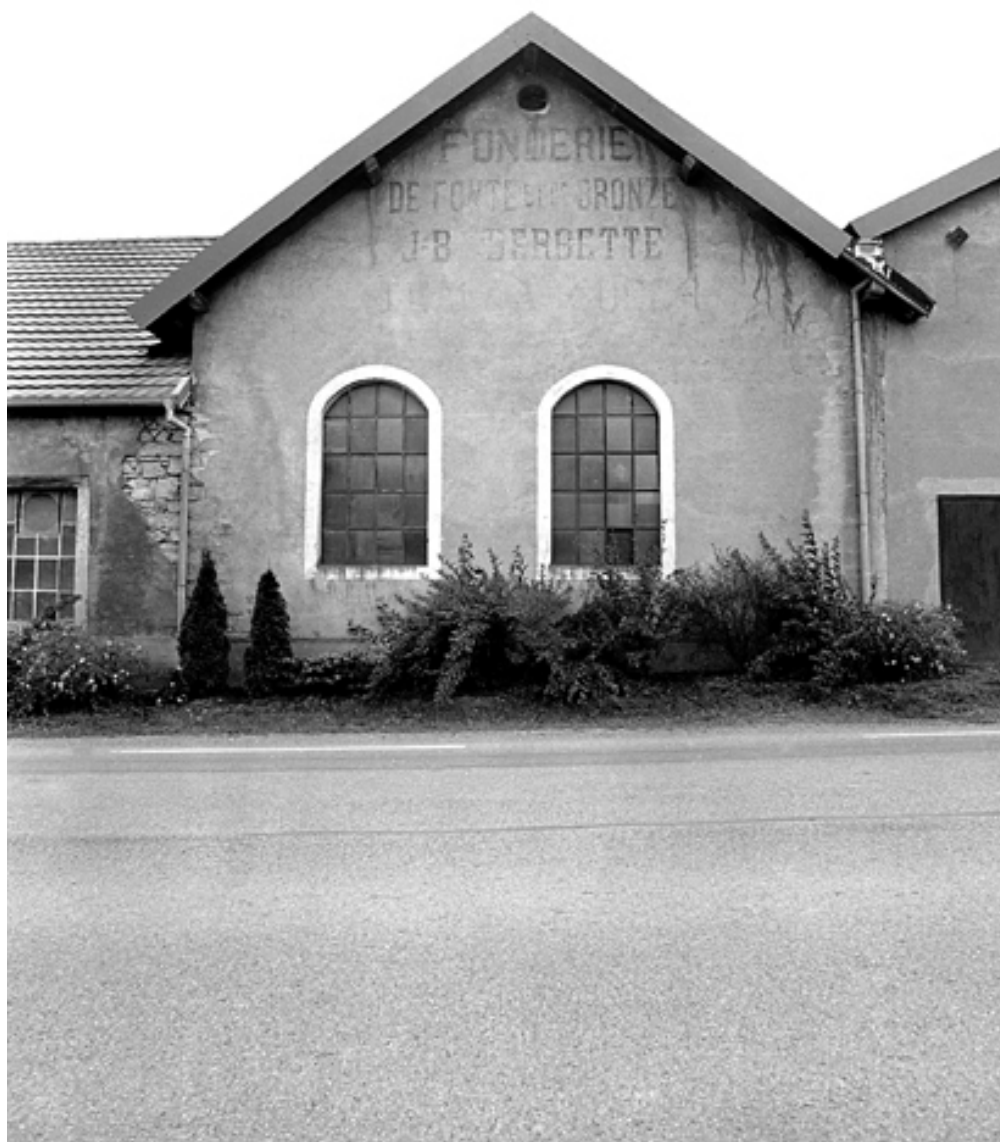
Mur-pignon d'un atelier de fabrication.
