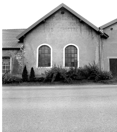
Mur-pignon d'un atelier de fabrication.
